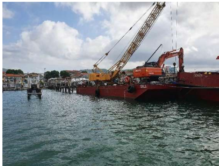
Figura 46. Il pontone presente nell'area di intervento.
