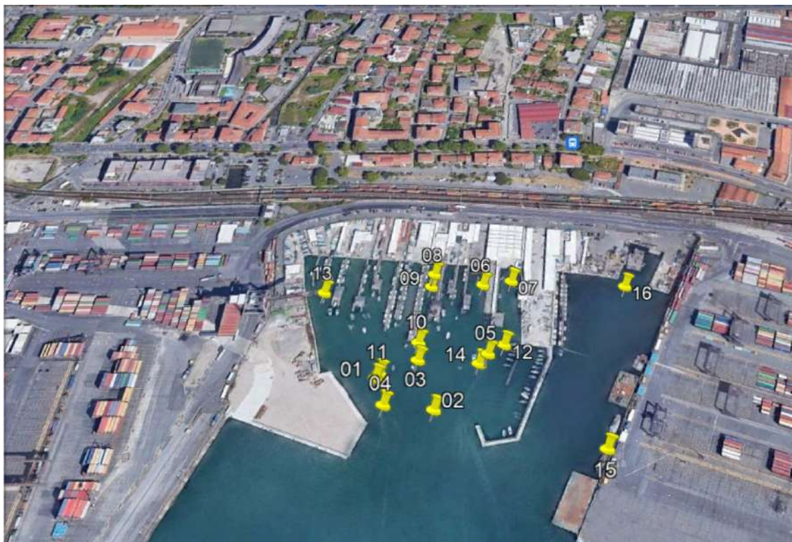
Figura 43. Posizione anomalie più significative su immagine aerea
