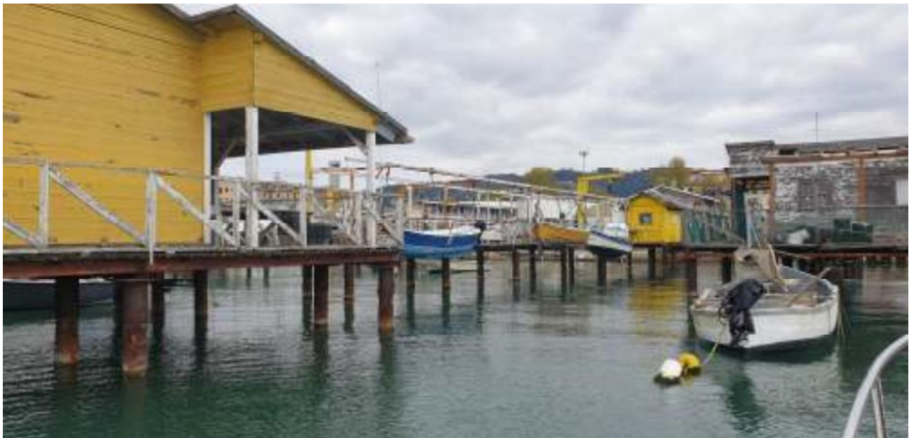
Figura 4 Darsena Marina del Canaletto – Strutture esistenti
