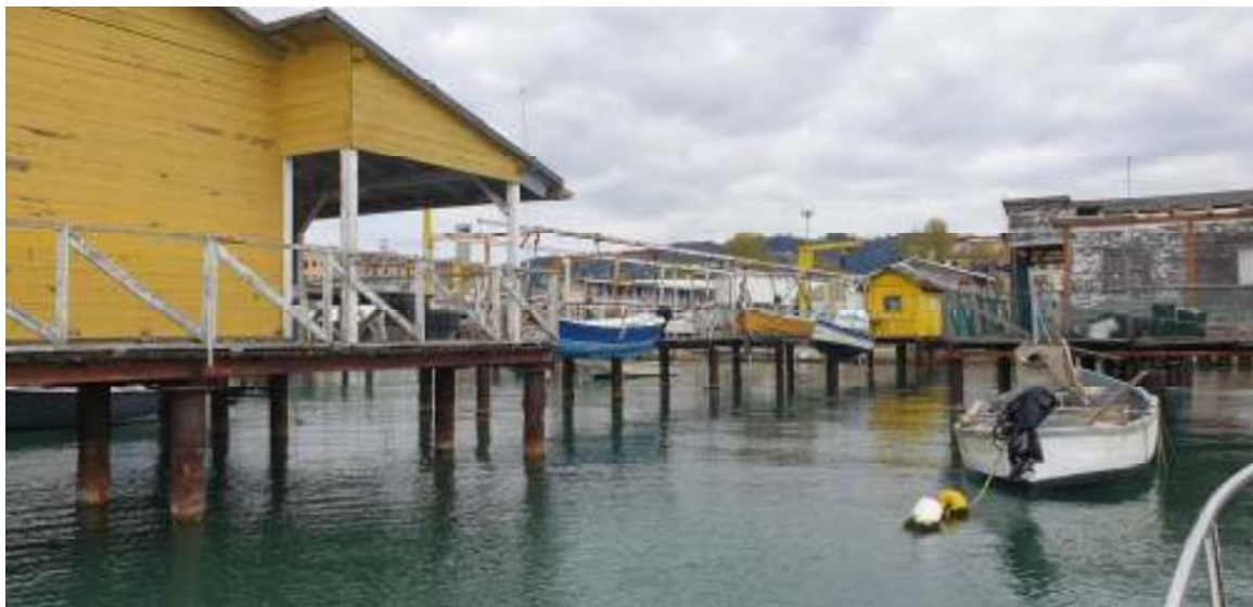
Figura 2-2 Darsena Marina del Canaletto – Strutture esistenti
