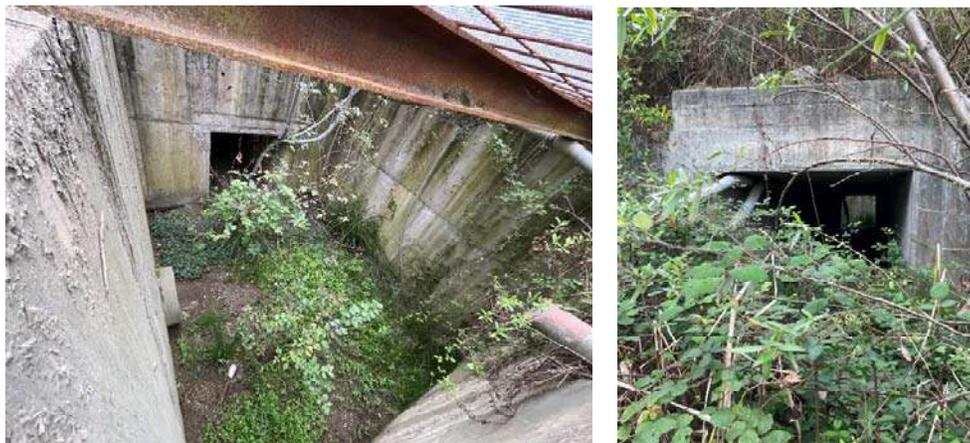
**Figura 10 – Pozzettone di drenaggio della porzione di monte della vallecola.**
