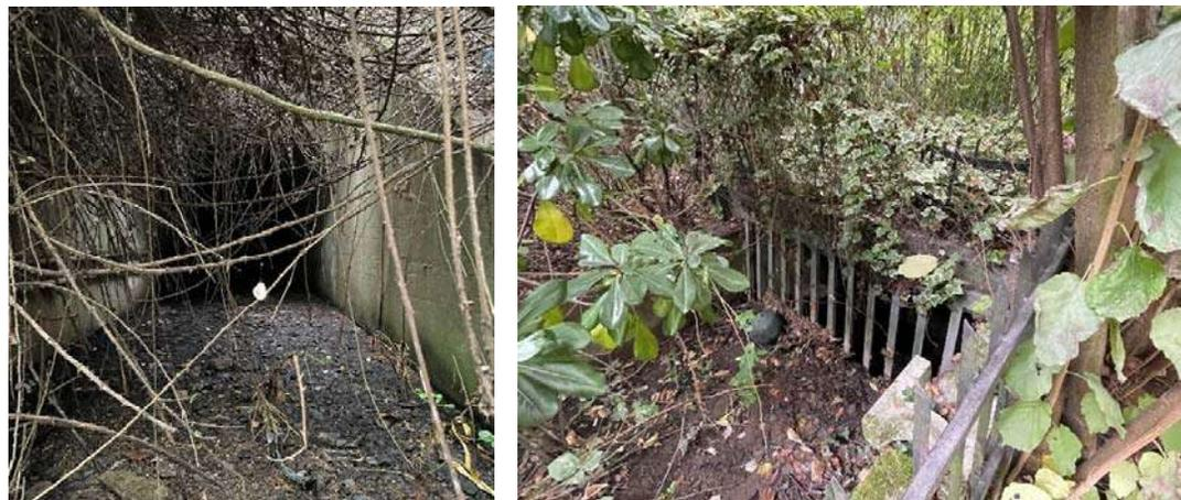
**Figura 12 – Sx: sbocco dello scatolare di attraversamento a valle ferrovia; dx: imbocco con successivo salto di fondo del manufatto di attraversamento profondo della linea ferroviaria.**
