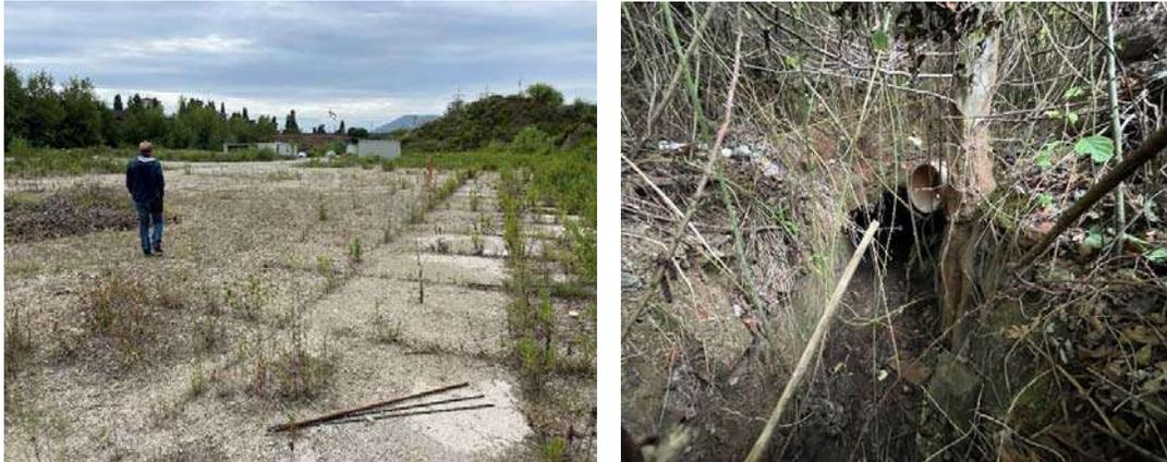
**Figura 11 – Sx: piazzale a valle dello sbocco del pozzettone, con segni di passati allagamenti; dx: sbocco di collettore tombato che si sviluppa al piede del versante destro.**
