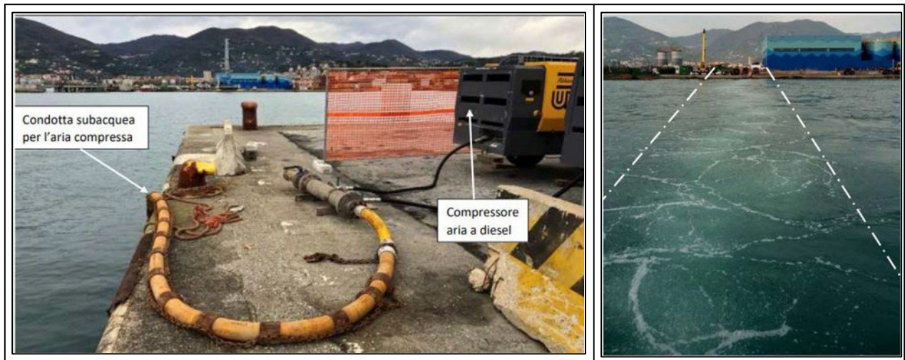
Figura 4 - Componenti del bubble screen adottato nel 2020-2021 alla Spezia ed effetto superficiale del confinamento dinamico tra Molo Fornelli e Molo Garibaldi durante tali lavori.
