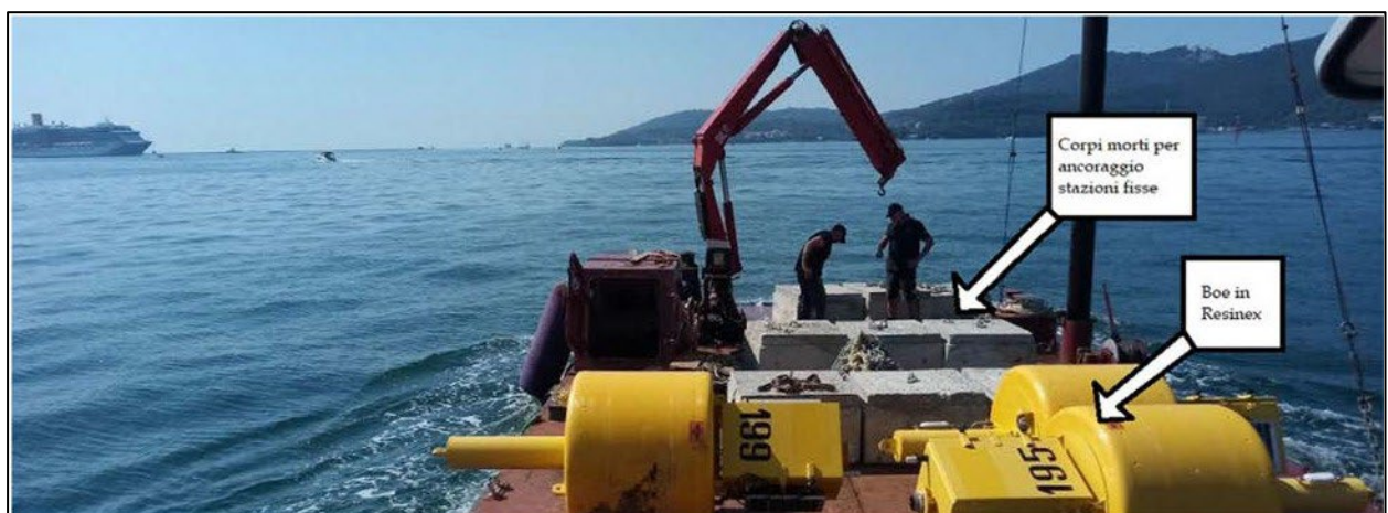
Figura 13 - Pontone con braccio meccanico impiegato per il varo delle stazioni di AdSPMLOr nel 2020.
