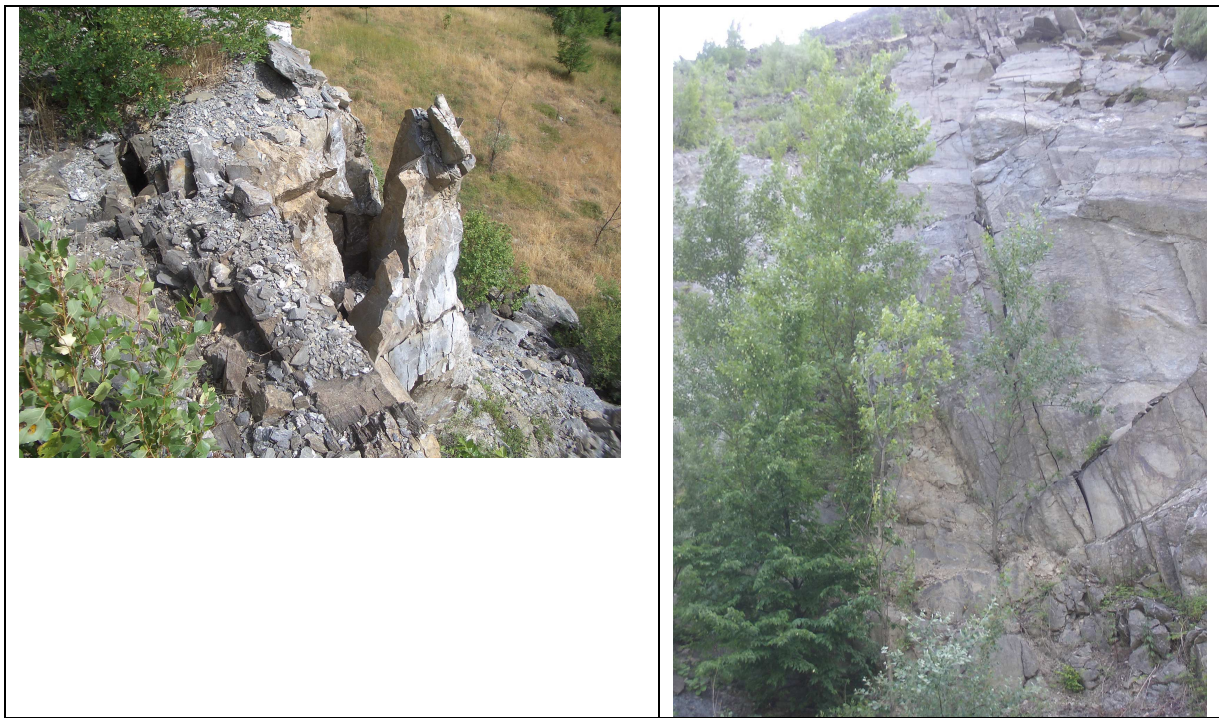
Figura 15: esempi di cinematismi di toppling (n. 6 a sinistra e n. 7 a destra).
