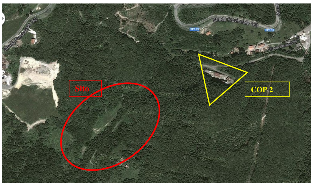
Figura 2-1 Ripresa aerofotografica dell’area di deposito intermedio del materiale e ubicazione rispetto al cantiere COP2
