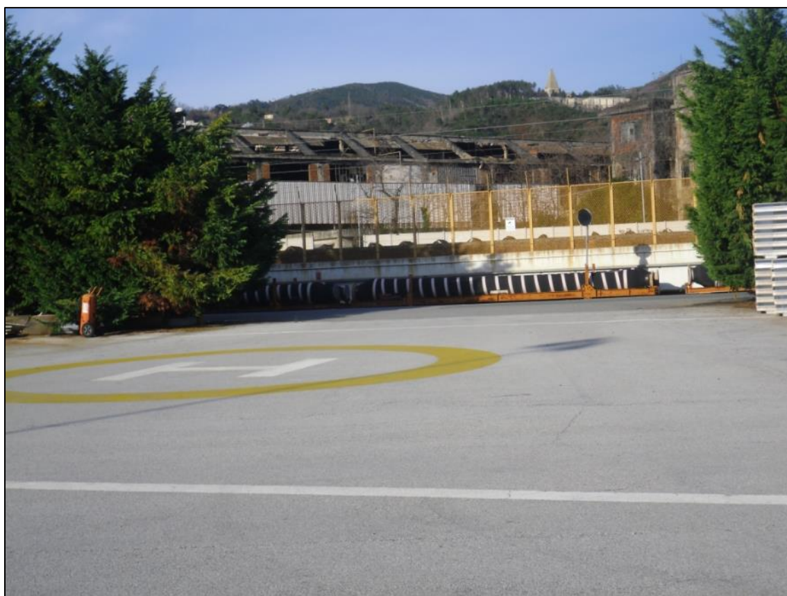
Figura 12. Porto Petrolì: area oggetto delle lavorazioni (eliporto) vista da S
