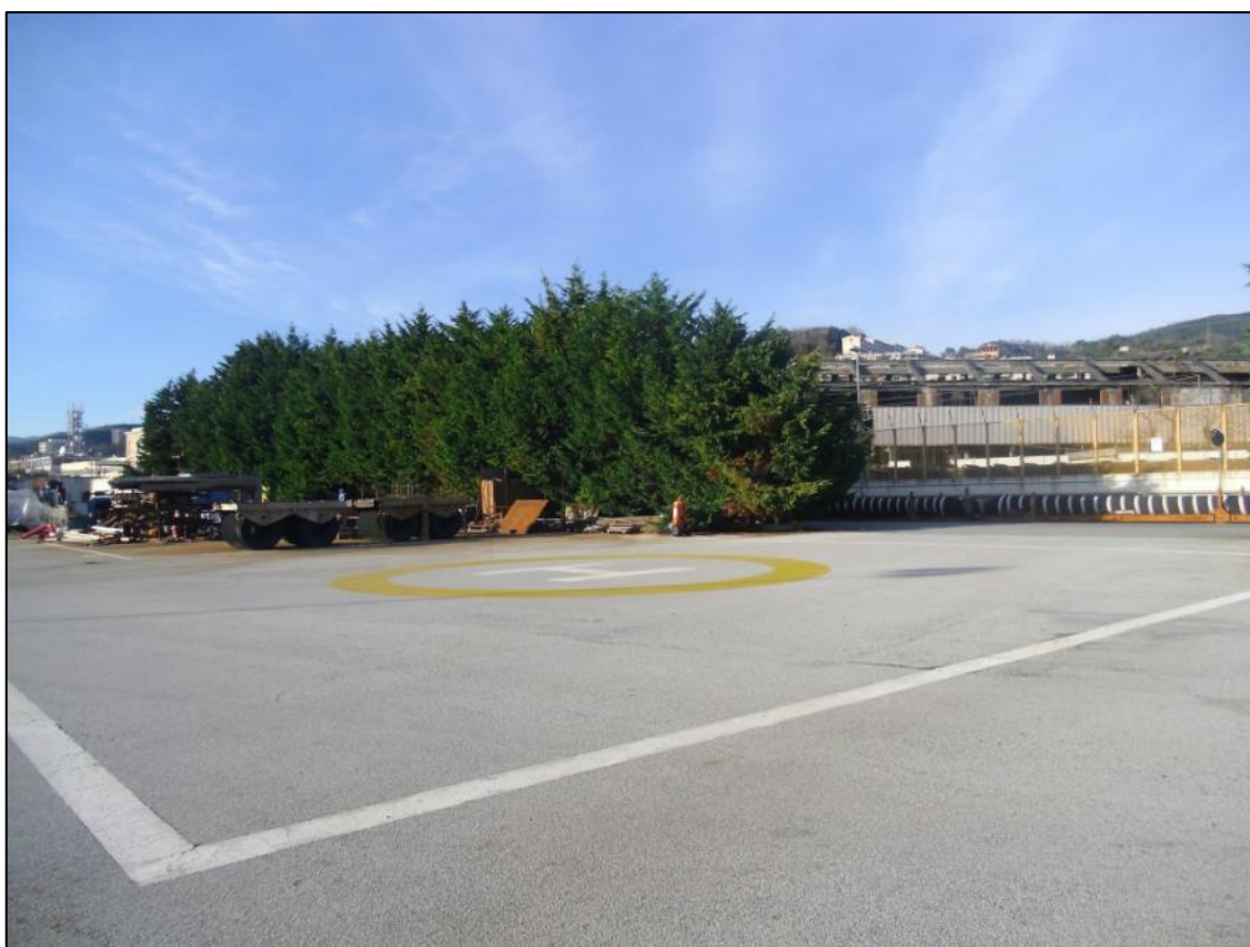
Figura 14. Porto Petroli: area oggetto delle lavorazioni (eliporto) vista da S-W
