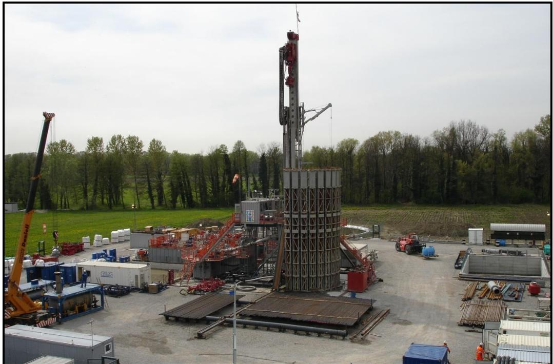
Man mano che la perforazione procede si pone la necessità di isolare le formazioni attraversate, per dare stabilità al foro costruito fino a quel momento. A tale scopo, nel foro viene collocata una tubazione (casing) come schematicamente rappresentato nelle *Figure 3.3.1a* e *3.3.2a* sopra riportate
