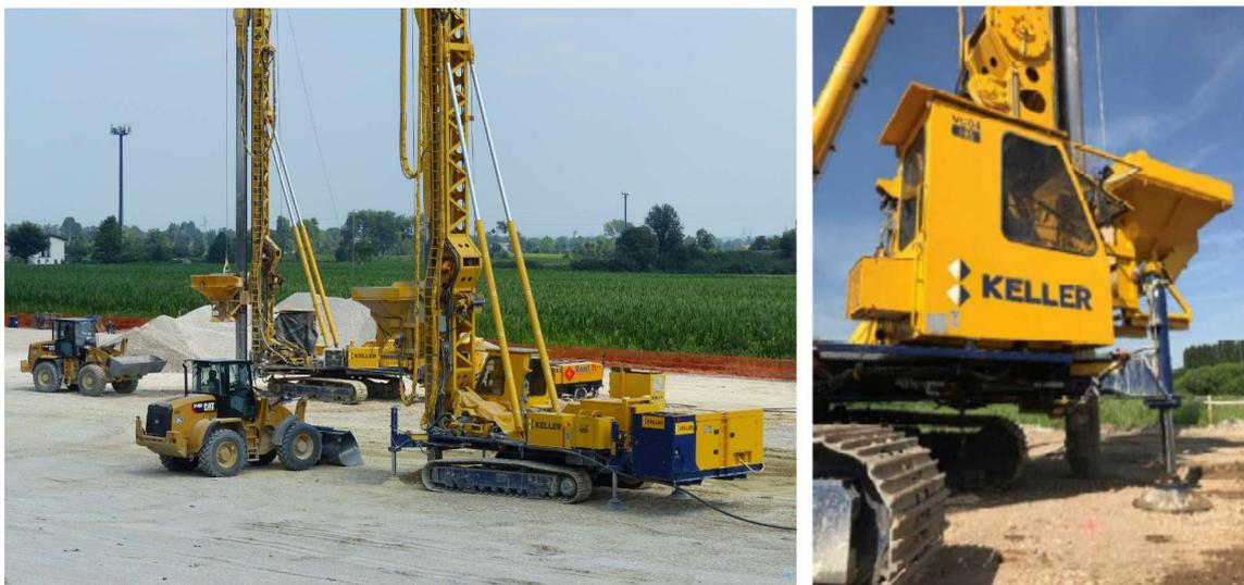
La macchina è attrezzata con una tramoggia frontale che permette, scorrendo sul mast, di approvvigionare, man mano nel corso della compattazione della colonna, la ghiaia cementata dalla sommità del vibroflot, dotato di specifico valvolone di carico.
