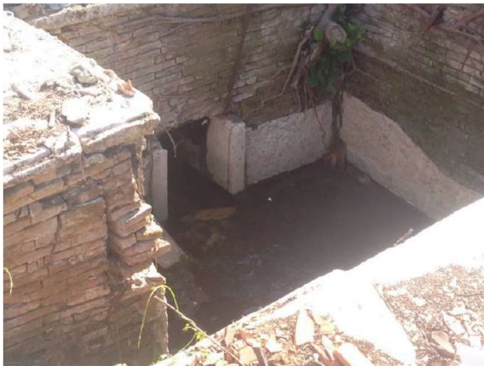
Figura 86 – Risorgiva “Mulino”: sezione di ingresso delle acque di risorgiva.
