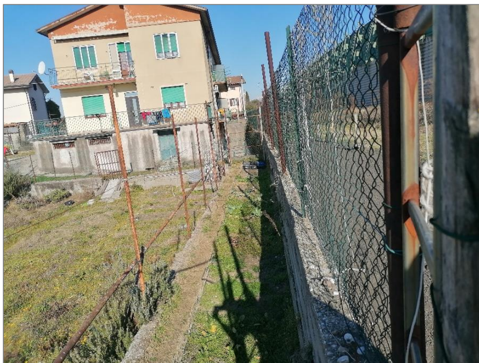
Figura 5 – Rilevato posto lungo il lato nord dell'area indagata, a margine della linea ferroviaria. (A) Nella porzione ovest, il rilevato è sostenuto da un muro di sostegno lungo il lato di valle (sinistra della foto). (B) Vista del muro di sostegno del rilevato e della porzione immediatamente a valle dello stesso.
