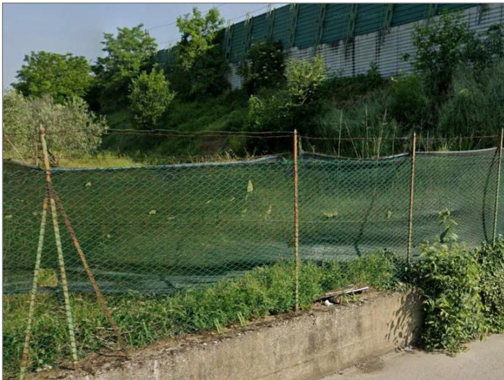
Figura 6 – Porzione del rilevato priva di muro di sostegno. (A) Al termine del muro di sostegno il rilevato è raccordato al piano campagna da una scarpata vegetata (vista verso est). (B) Porzione terminale del rilevato (vista da via Buri).
