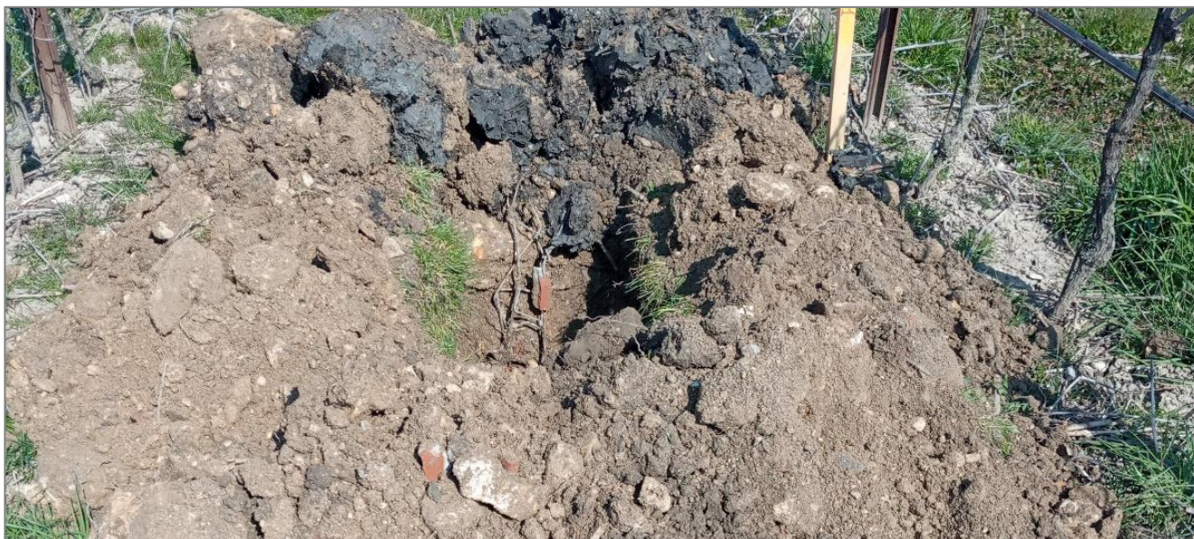
Figura 4 – Macerie da demolizione rinvenute nel primo metro di scavo della trincea esplorativa SC06_T01.
