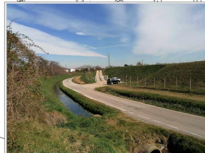
SC07 Vista del rilevato della discarica (accesso lato Via Stazione)
