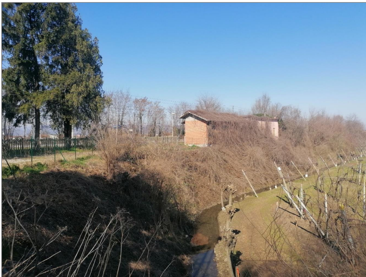
Figura 3 – Ripresa fotografica del sito SC08 dall’attraversamento lungo via Trassegno. È possibile osservare la presenza di due edifici nel settore posto a margine della ferrovia, così come il corso d’acqua che divide il sito dalla porzione di coltivi presente sulla destra nell’immagine riportata.
