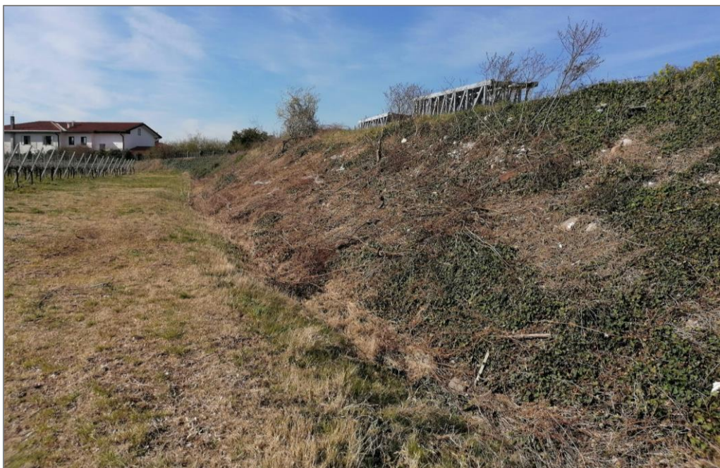
Figura 3 – Vista della scarpata del rilevato e del punto di raccordo con il piano campagna, caratterizzato dalla presenza di coltivi, a sinistra nella foto (Foto 2 in Fig. 3).
