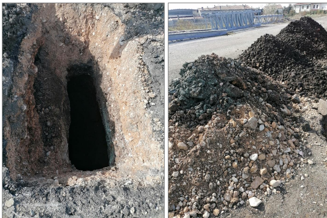
Figura 7 – Trincea esplorativa SC09_T09. Nell'immagine di sinistra è visibile lo scavo realizzato lungo le cui pareti si riconosce, al di sotto del tappetino centimetrico di asfalto, un livello di 1 m di spessore circa di ghiaie in matrice sabbioso-limosa rossastra. A destra, accanto al cumulo del materiale del primo metro sono visibili i cumuli del materiale sottostante, rappresentato da ghiaie e ciottoli in matrice limoso-sabbiosa scura, con ballast ferroviario.
