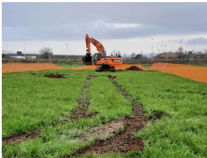
Figura 4-1 – Scavi di splateamento presso la WBS GA01 nel periodo di riferimento
