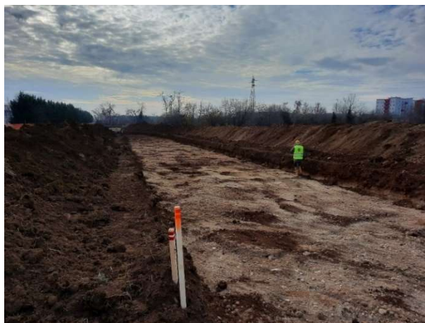
Figura 4-2 – Scavi di splateamento presso il cb 1.1 – Verona est nel periodo di riferimento
