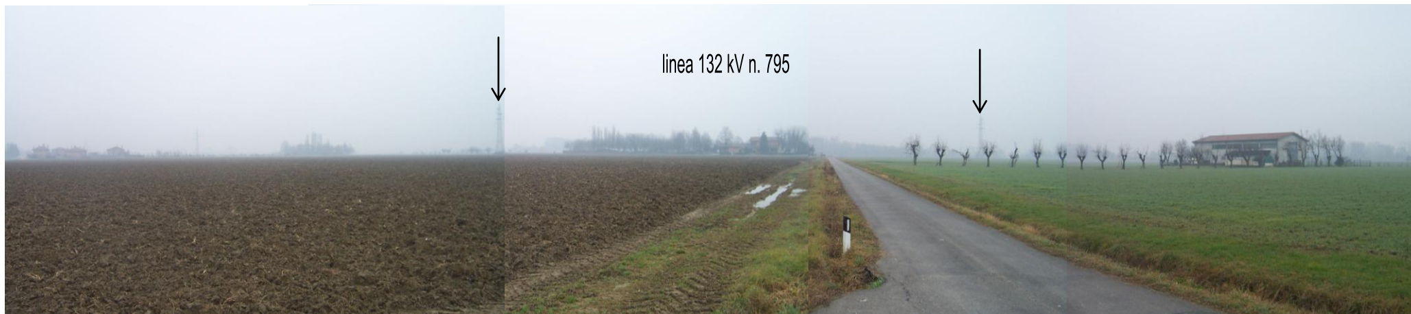
Particolare fotografico n. 9: panoramica ripresa in direzione Sud Est, a lato della via XXI Ottobre 1944, tra le località "Colombara" e "Corazzina". Sullo sfondo sono indicati i sostegni della linea 132 kV n.795.
