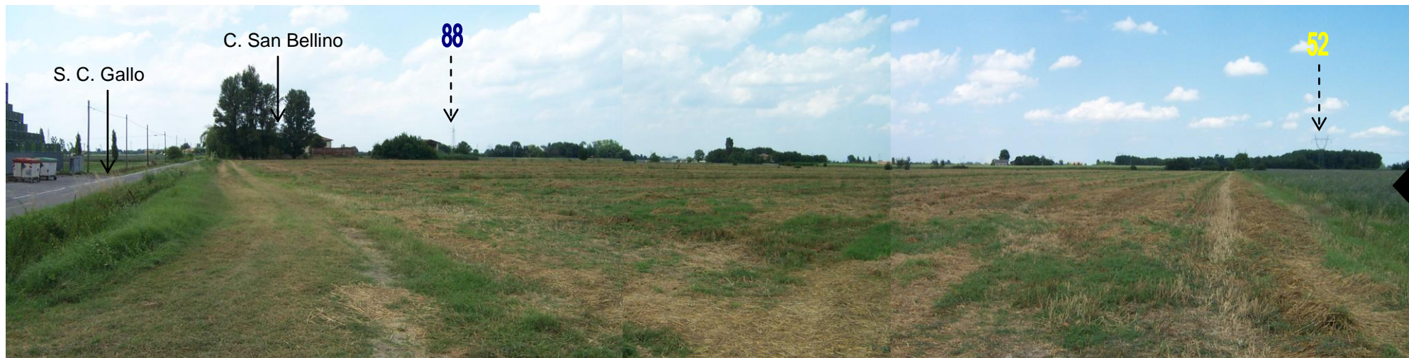
Particolare fotografico n. 3 : Vista panoramica verso Nord Ovest del collegamento “sud” tra la C. P. Altedo e la linea ex220 kV n. 226, nei pressi della S. C. Gallo, in località La Castiglia.
