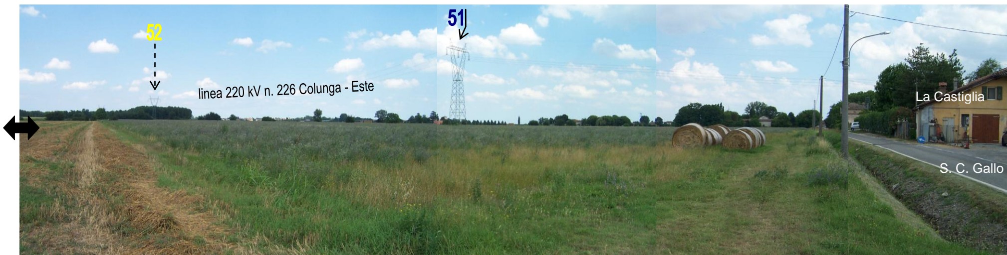
Particolare fotografico n. 4 : (in continuità con la precedente) Vista panoramica verso Est del collegamento “sud” tra la C. P. Altedo e la linea ex220 kV n. 226, nei pressi della S. C. Gallo, in località La Castiglia.
