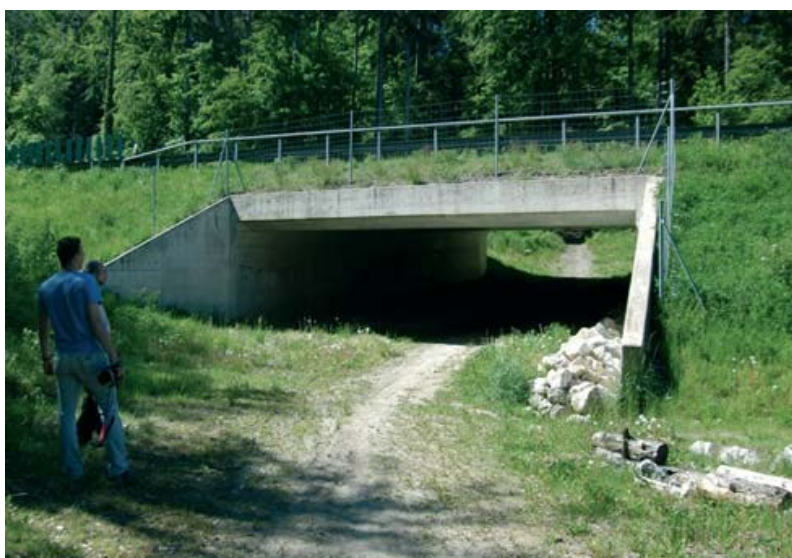
Sottopasso ad uso faunistico lungo una sterrata per il traffico locale. Si notino le fasce erbose ai margini e la fila di sassi. Tratta da Fila Mauro et al., 2005.
