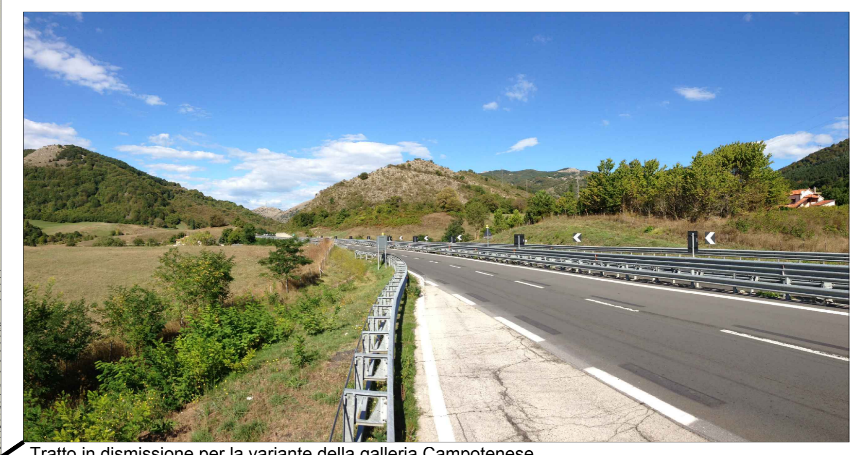
Tratto in dismissione per la variante della galleria Campotense
