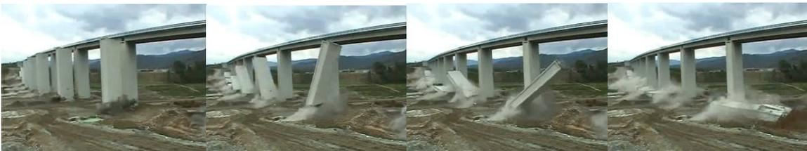
*Figura 16 – Sequenza fotografica della demolizione sequenziale di più pile di un viadotto in blocchi massivi; (si noti la predisposizione di letti di smorzamento per la riduzione delle vibrazioni da impatto, e la prossimità di un ulteriore viadotto non destinato alla demolizione).*
