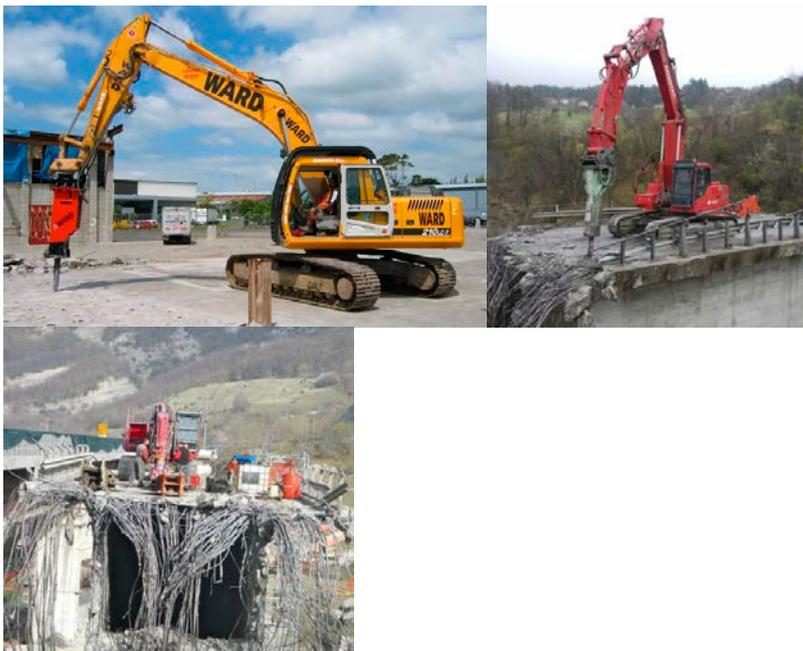
*Figura 1 – Esempi di escavatore con martellone idraulico: le figure mostrano l'impiego di un escavatore con martellone idraulico per la demolizione tradizionale di un viadotto; l'escavatore posizionato sull'impalcato è comandato in remoto a mezzo di comandi a distanza e monitor per salvaguardare l'incolumità dell'operatore.*
