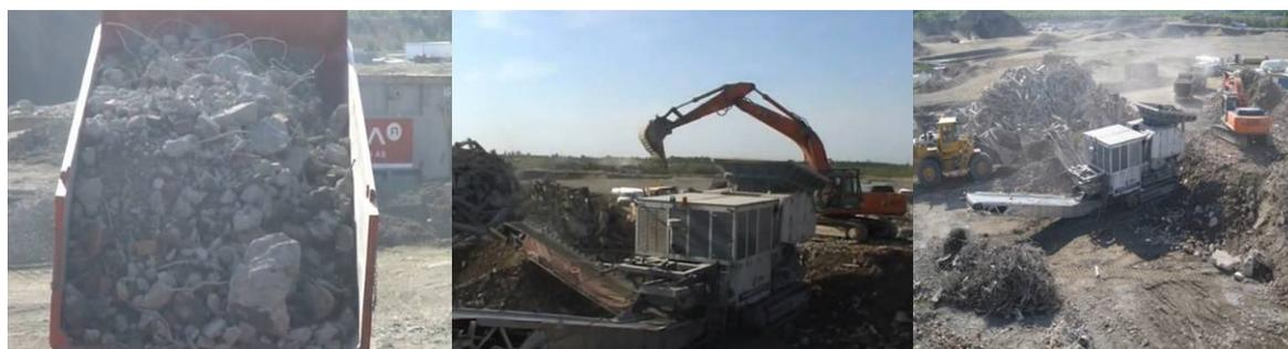
*Figura 4 –Fasi di lavorazione dell'area di allestimento del frantoio mobile: 1) Movimentazione 2) Carico della tramoggia di alimentazione del frantoio 3) separazione dei flussi inerti e metallici*
