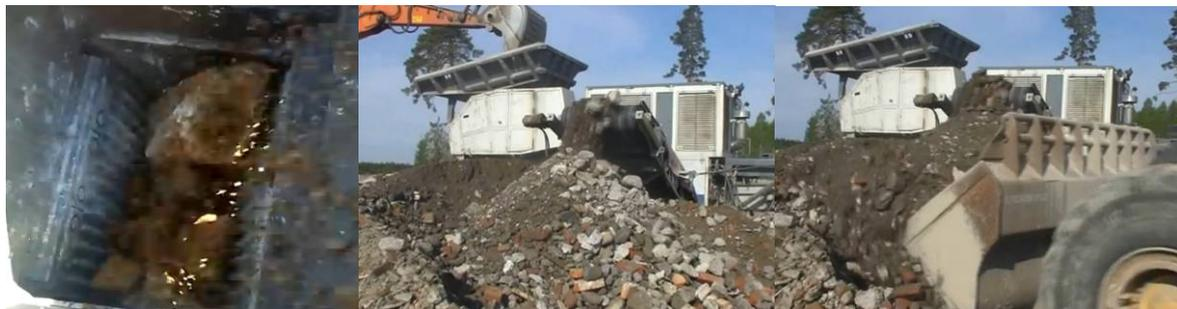
*Figura 5 –particolare delle mascelle di demolizione e del nastro trasportatore di recupero dei difiuti da demolizione del calcestruzzo da destinare a discarica di rifiuti inerti*
