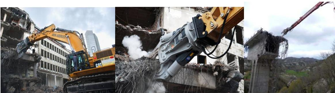
Figura 2 – Esempi di escavatore con pinze idrauliche: le figure mostrano l'impiego di un escavatore a pinze demolitrici per la demolizione di opere strutturali in CLS tra cui un viadotto.
