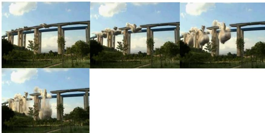
Figura 13 –Sequenza fotografica della demolizione simultanea di più impalcati di un viadotto in blocchi massivi
