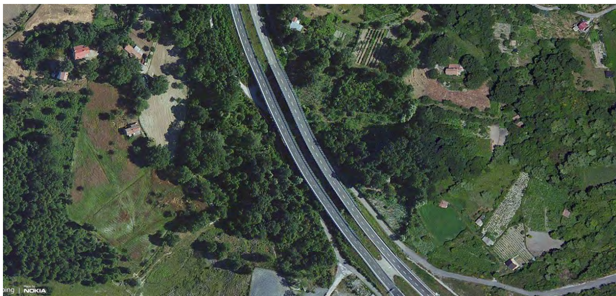
Foto 0102ix: Viadotto GALLARIZZO N+S NON È DA DEMOLIRE
