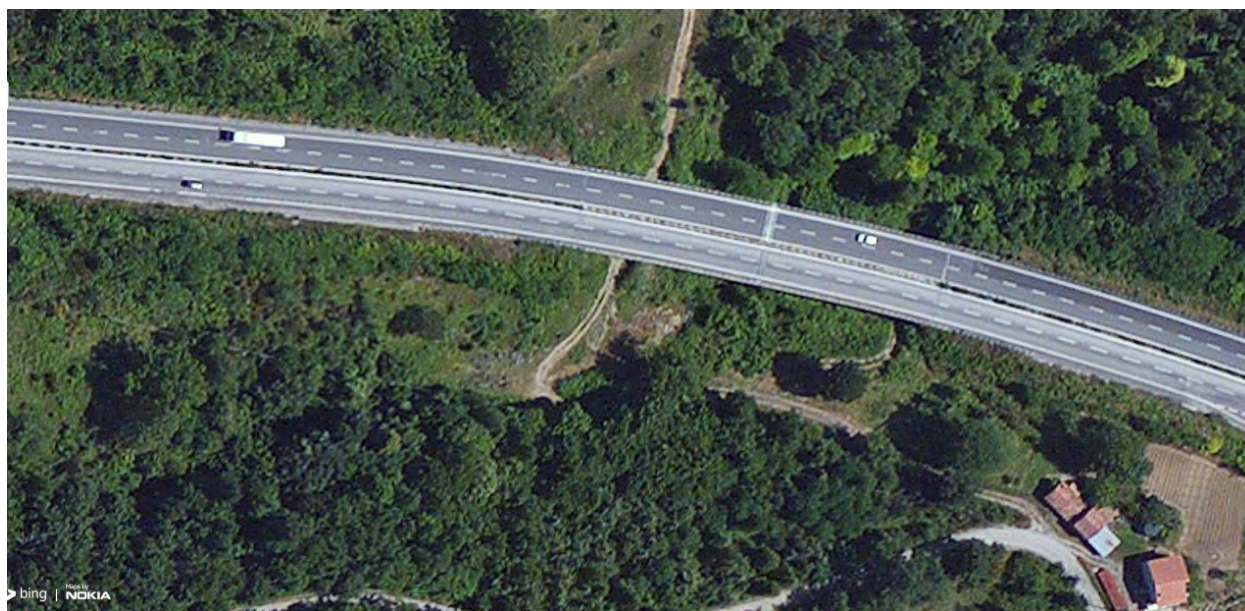
Foto 0102ii: Viadotto PANTANO N+S
