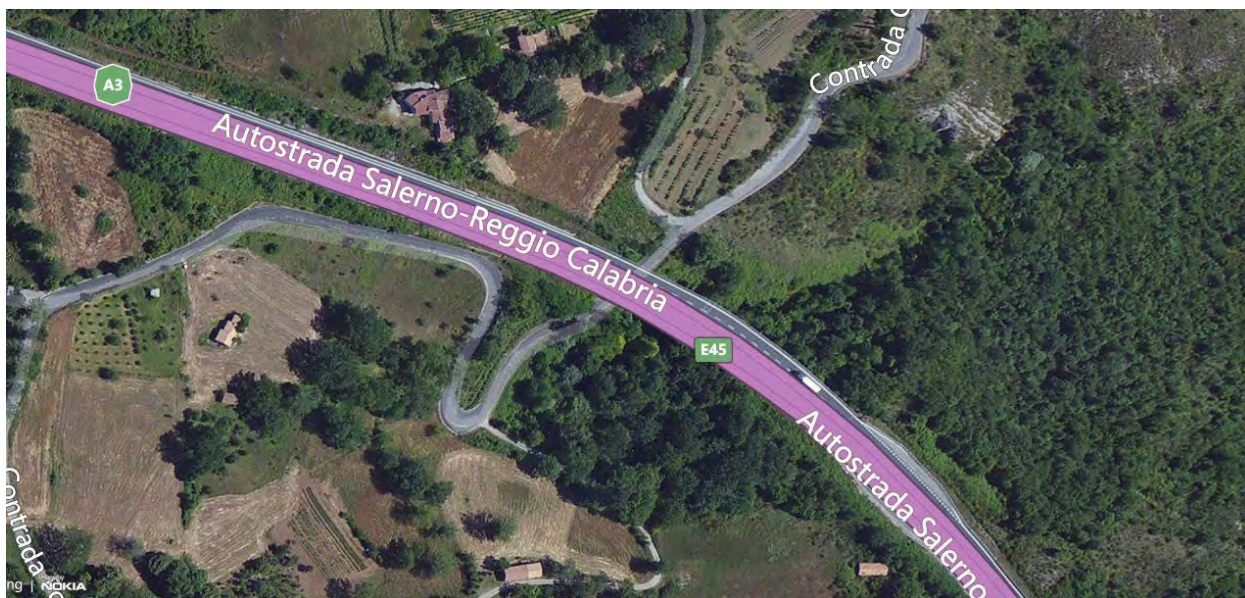
Foto 0102iv: Viadotto FORNO N+S
