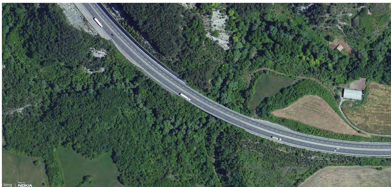
Foto 0102xvi: Viadotto BATTENDIERO II N+S
