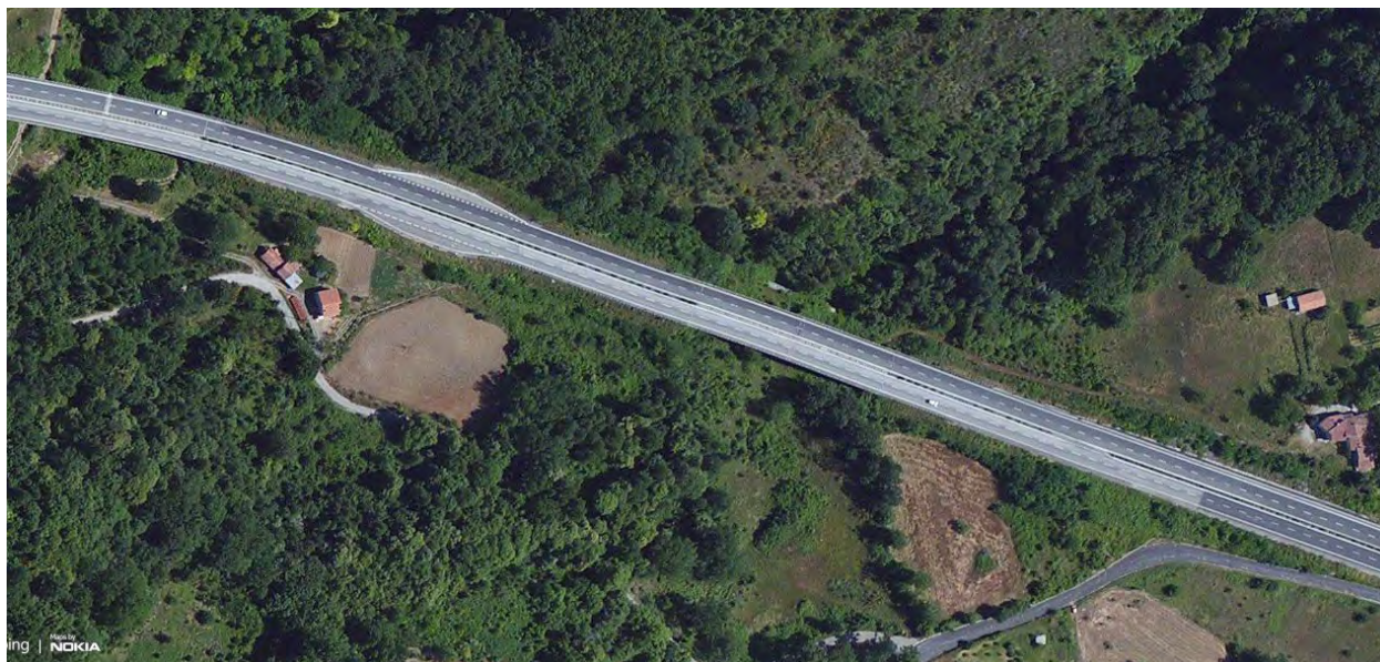
Foto 0102iii: Viadotto CAPOLANZO N+S
