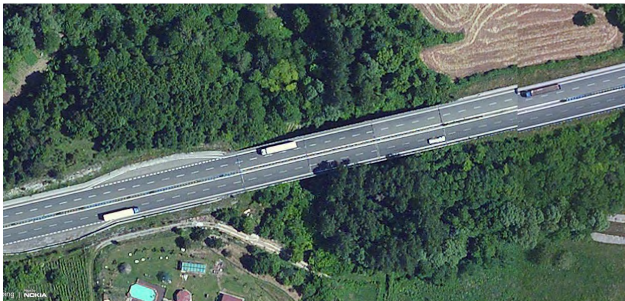
Foto 0102xvii: Viadotto BATTENDIERO III N+S
