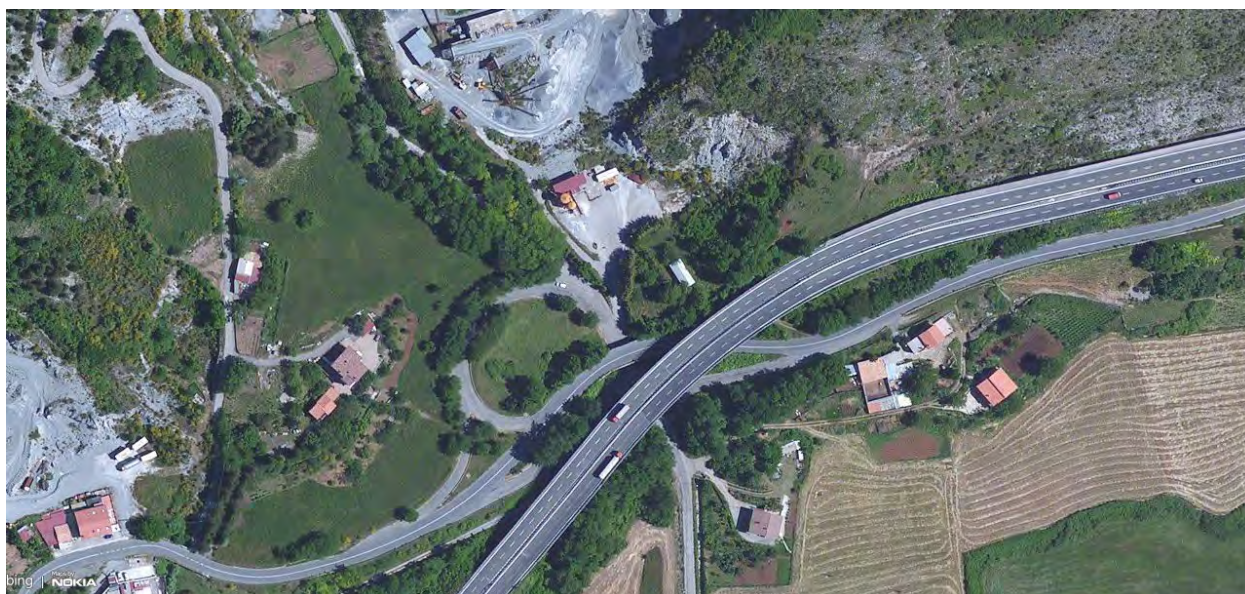
Foto 0102xviii: Viadotto VALLONE MANCUSO II N+S
