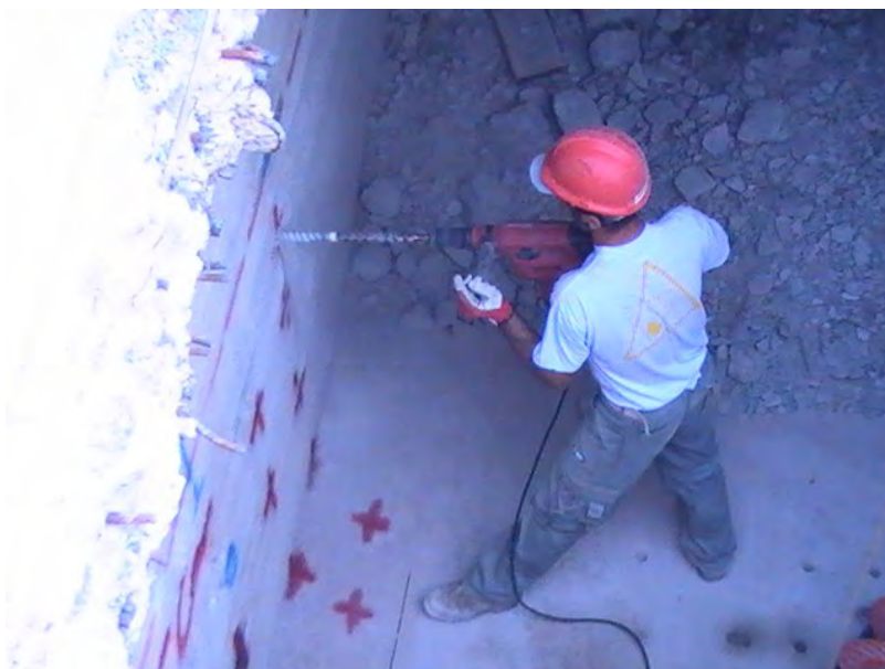
Perforazione con martello elettrico
