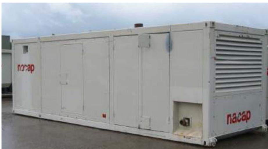
*Figura 4.14: unità pompaggio fanghi*
