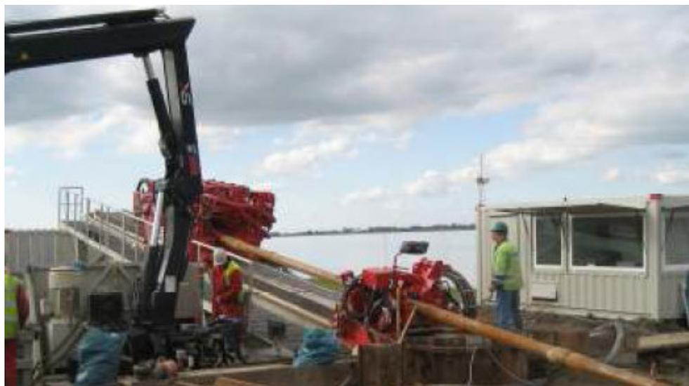
*Figura 4.12: tubi di perforazione da 6 5/8".*
