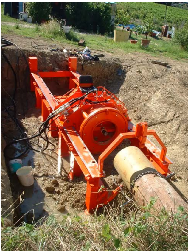
Fig. 11 – Attraversamenti con trivella spingitubo
