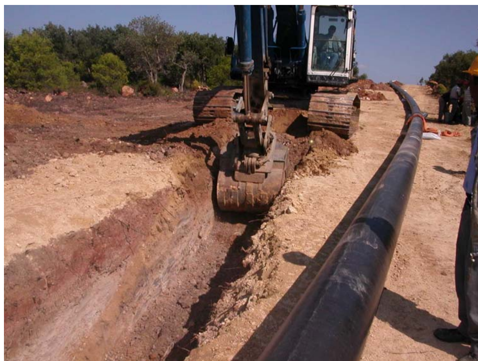
Fig. 8 – Scavo trincea di posa
