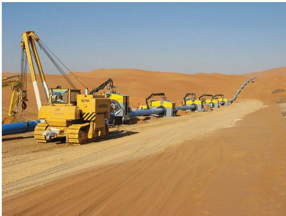
Fig. 5 – Saldatura tubi (1)
