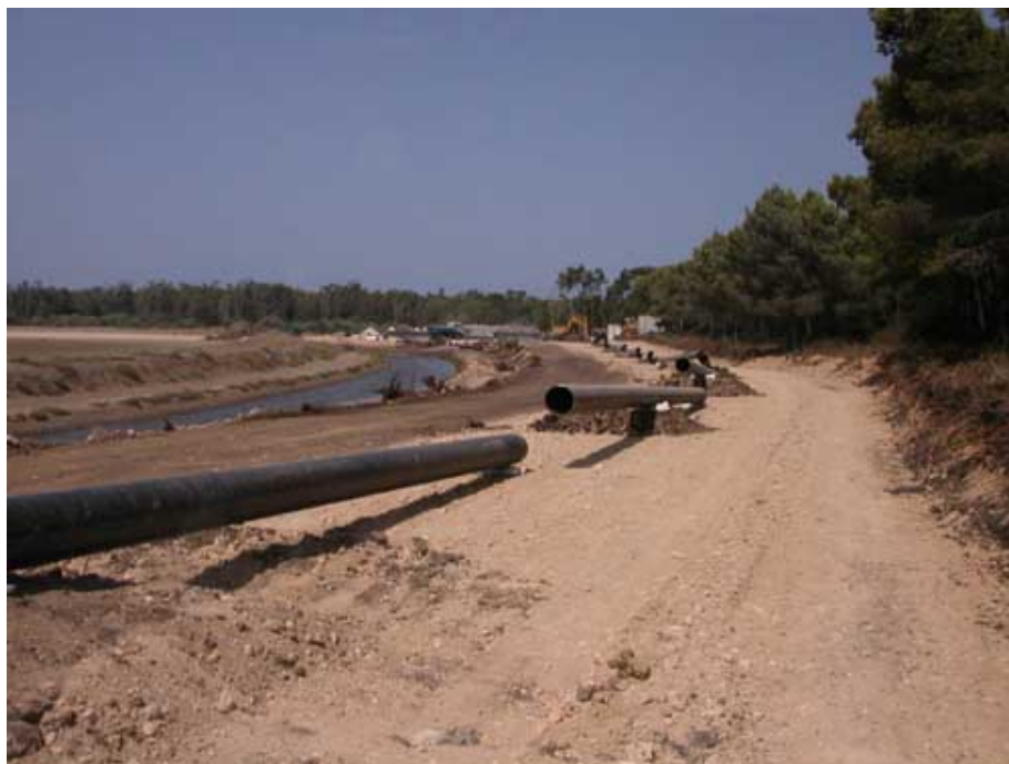
Fig. 4 – Sfilamento tubi (2)
