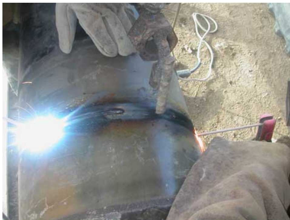
Fig. 6 – Saldatura tubi (2)
