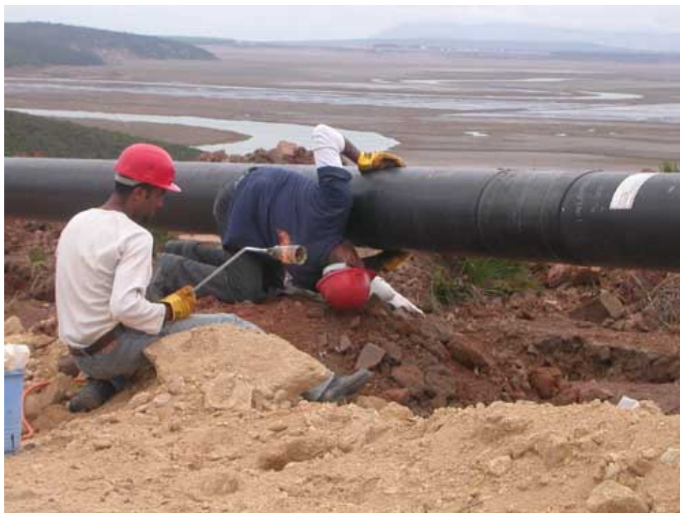
Fig. 7 – Fasciatura giunti
