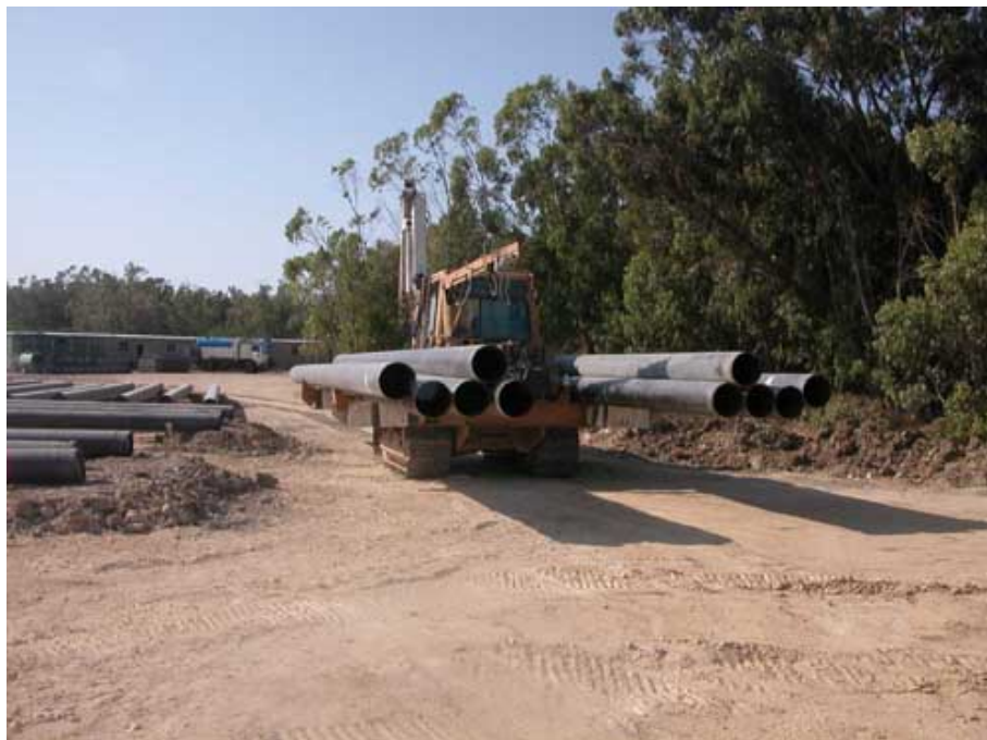
Fig. 3 – Sfilamento tubi (1)
