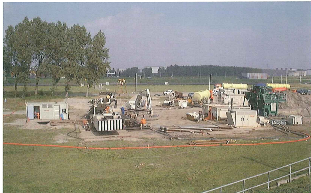
IMMAGINE DI UN CANTIERE A TERRA
