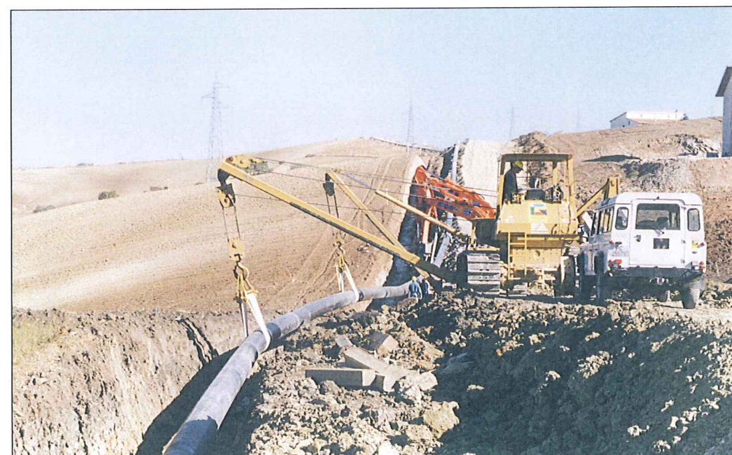
POSA DELLA CONDOTTA
