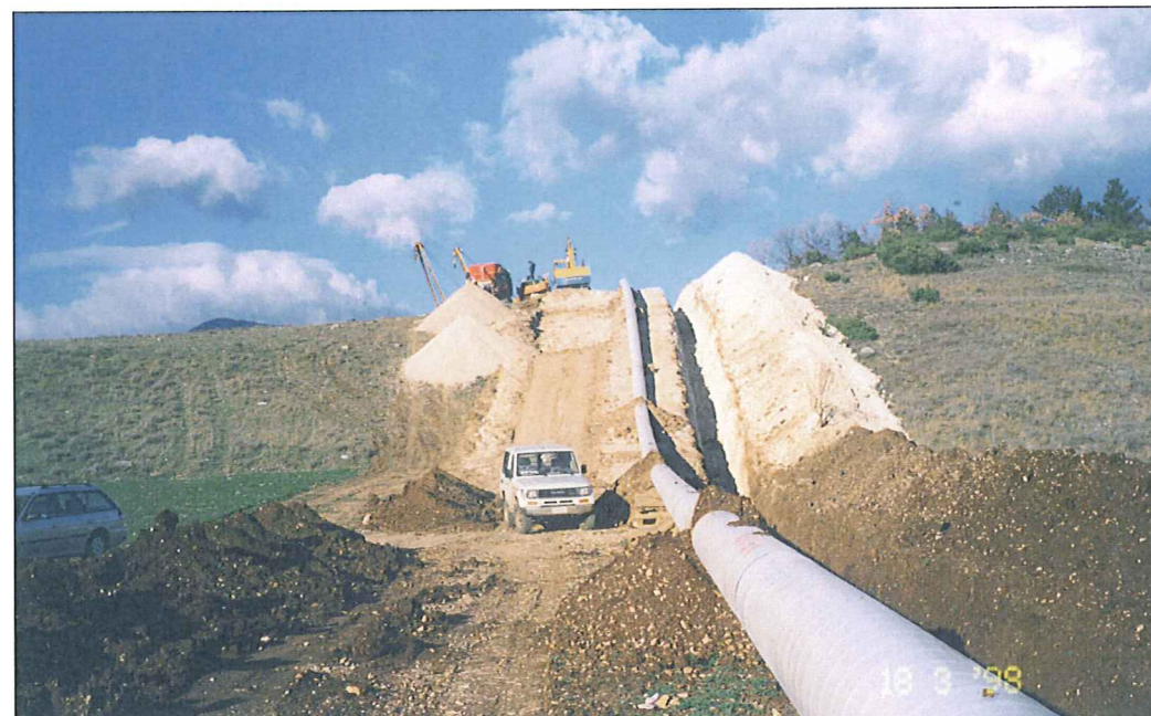
SCAVO DELLA TRINCEA
