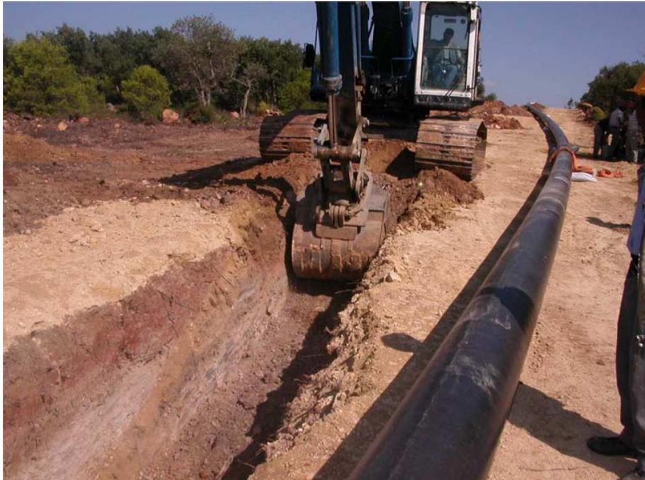
**Figura 3.4: Esempio di Scavo della Trincea di Posa**
