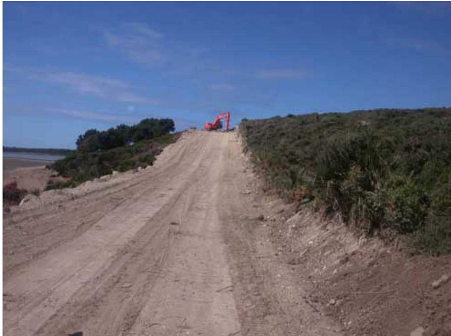
**Figura 3.3: Esempio di Apertura di una Pista di Cantiere**
