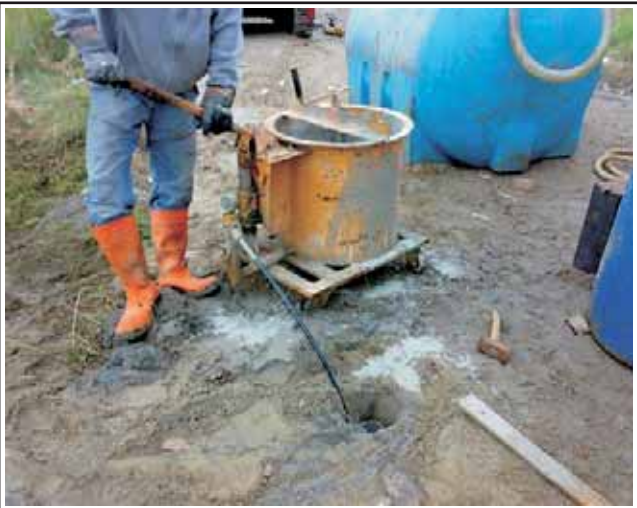
Iniezione di cemento
