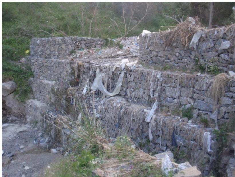
**Figura 15: una delle briglie a gabbioni esistenti nel tratto superiore del Guidari**
