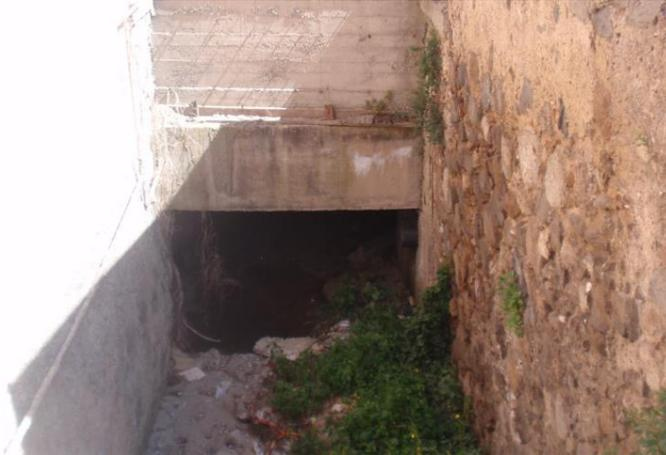
**Figura 5: tombinamento al di sotto della ferrovia**
