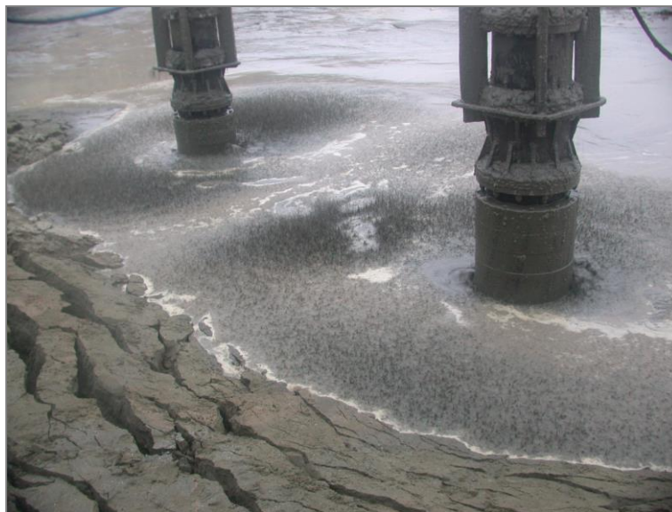
Figura 57 – Particolare delle sonde introdotte nel terreno.
