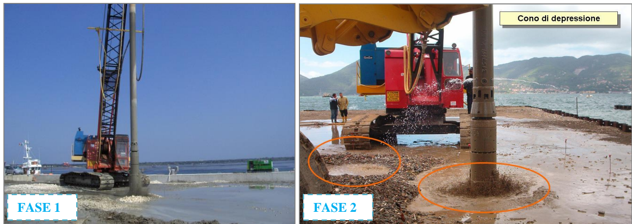
Figura 54 – Vibroflottazione: fasi esecutive 1 e 2.
