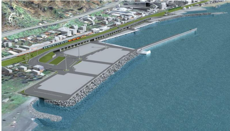
Figura 4 – Vista d'insieme area portuale
