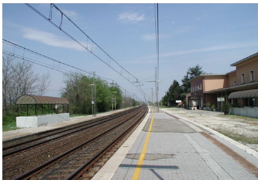
Figura 5 - Vista delle banchine di stazione.
