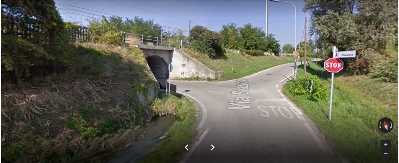
Figura 9 - Stato attuale – Vista su Via Stazione
