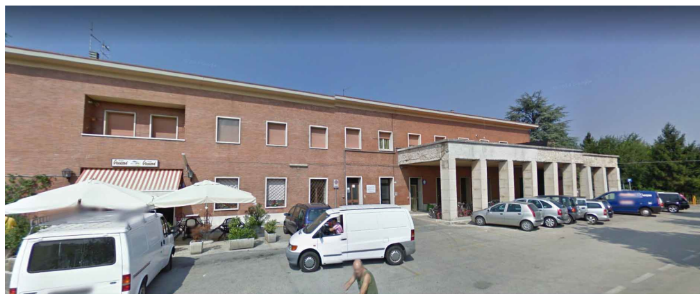
Figura 11 - Stato di fatto
