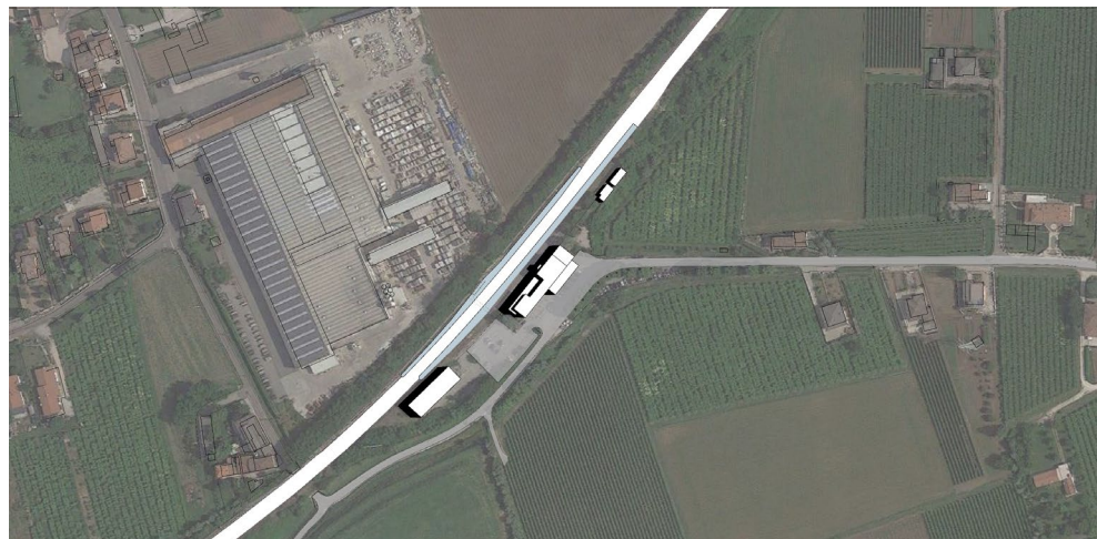
Figura 10 - Stato attuale – Vista su Via Stazione
