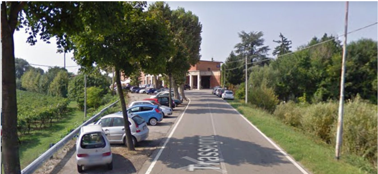
Figura 8 - Stato attuale – Vista su Via Trassegno verso curva stazione.
