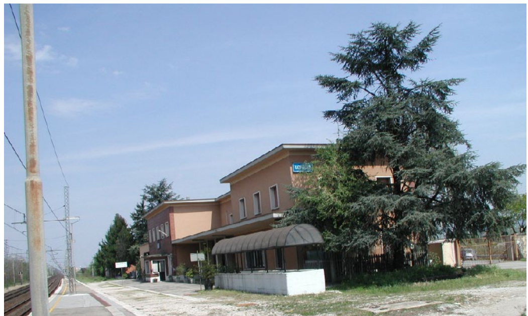
Figura 3 - Stato attuale – F.V. e l'accesso al sottopasso esistente: entrambi da demolire
