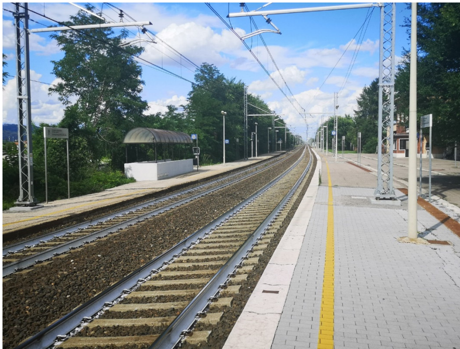
Figura 2 – Pali e linee di alimentazione trazione ferroviaria. I pali in primo piano interferiranno con la pensilina delle banchine
