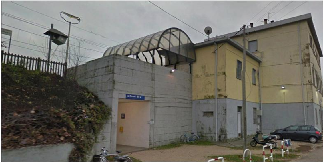
Figura 6– Stato attuale – accesso alla stazione
