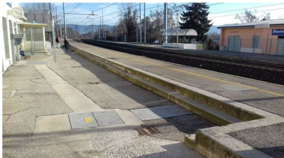
Figura 28 Banchina lato nord esistente
