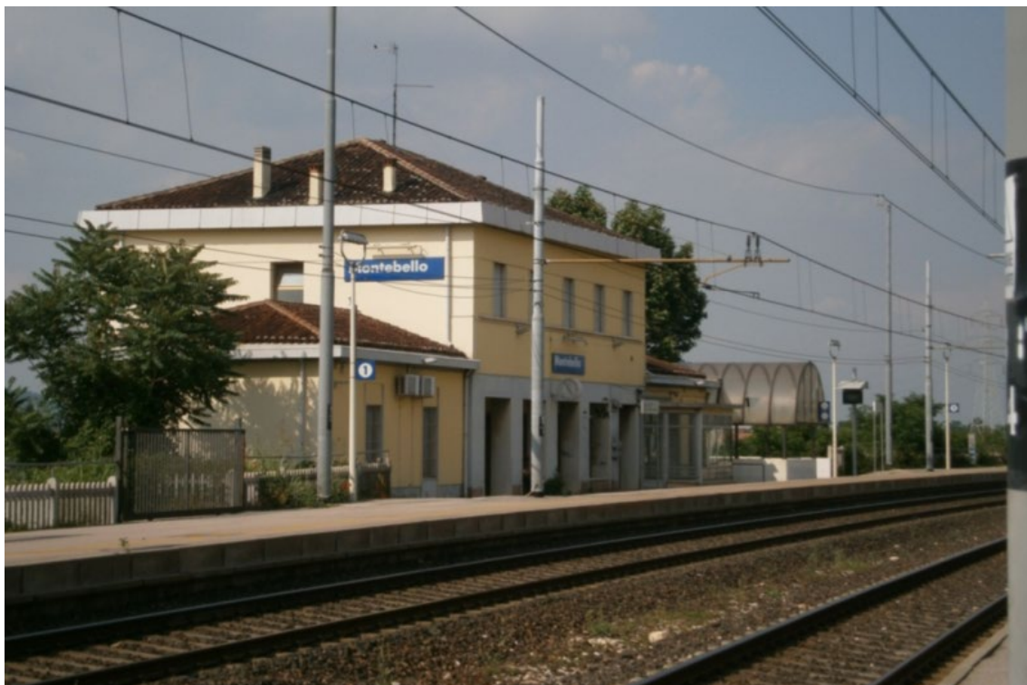
Figura 7– Stato attuale – vista da centrale elettrica a sud
