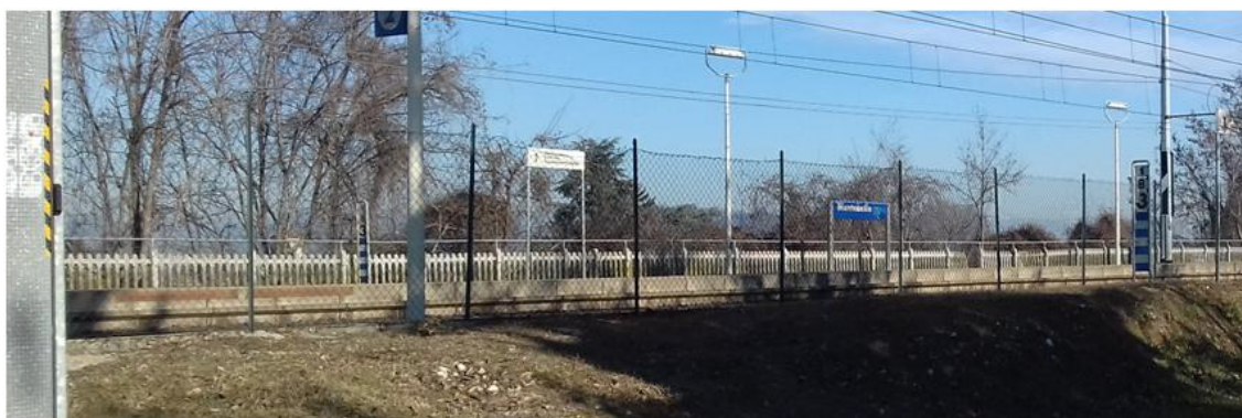
Figura 24 Recinzione perimetrale esistente
