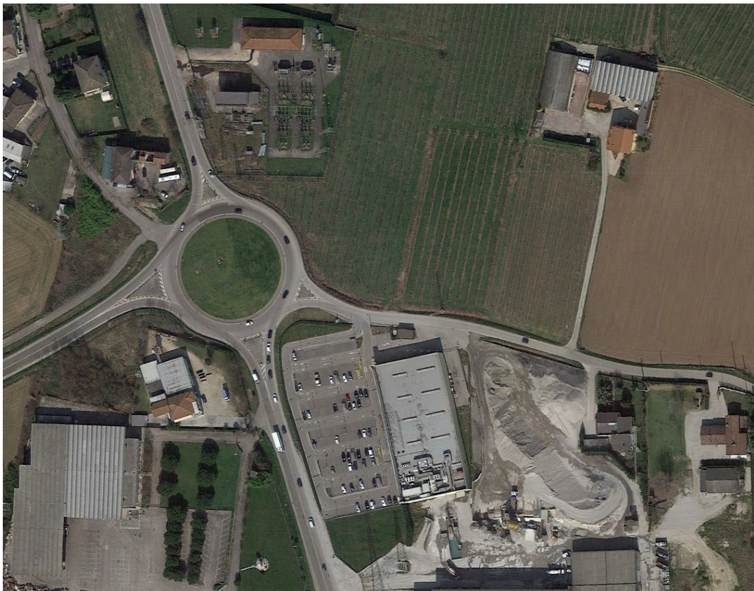
Figura 1: Stato di fatto
