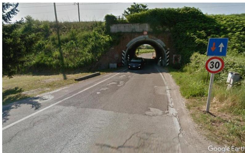
Oltre a quanto appena descritto da un punto di vista planimetrico, anche il franco altimetrico dell'opera esistente risulta essere particolarmente ridotto e pari a soli 3.00 m. L'opera di progetto invece presenta un franco altimetrico di 5.8 m.
