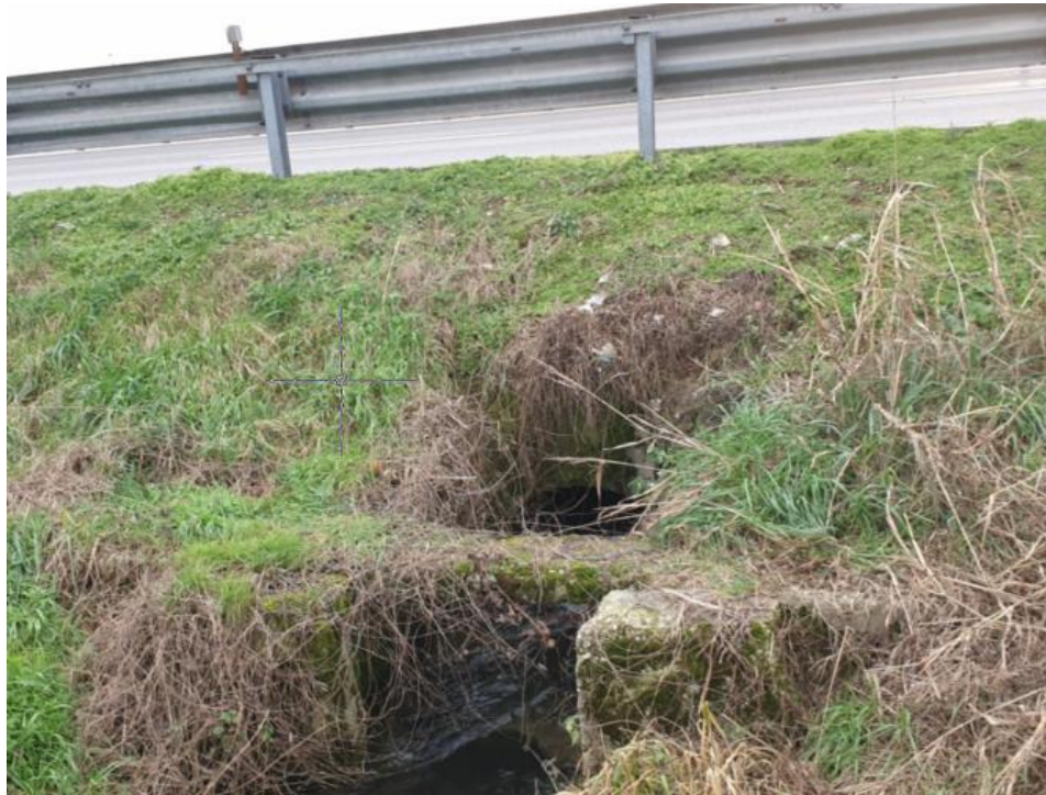
Figura 4 – Vista lato monte dell'attraversamento esistente sotto l'autostrada
