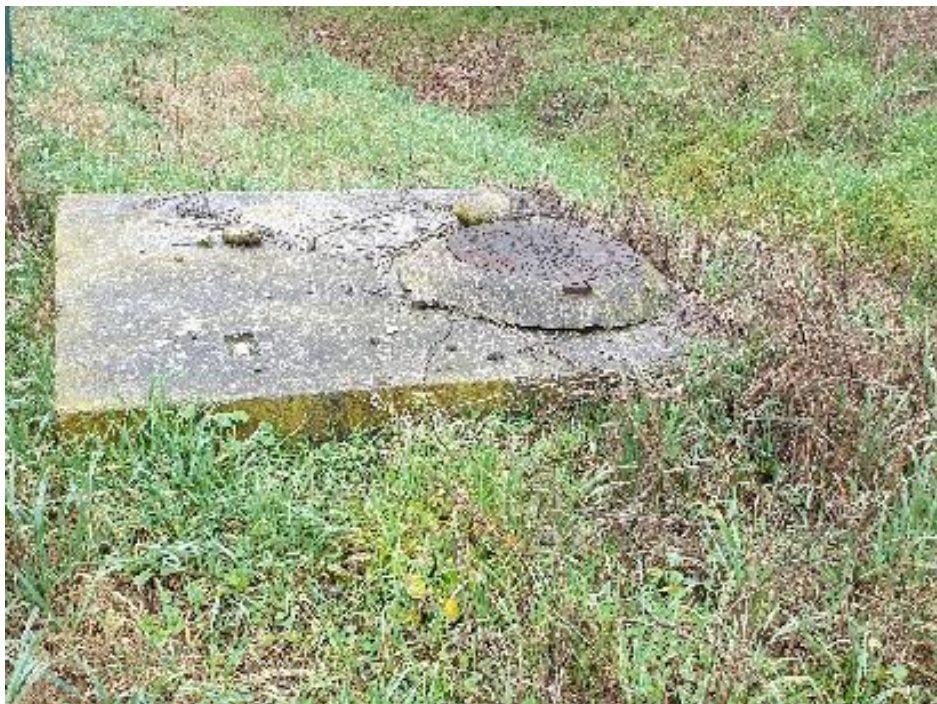
Figura 5 – Manufatto esistente a valle dell'autostrada
