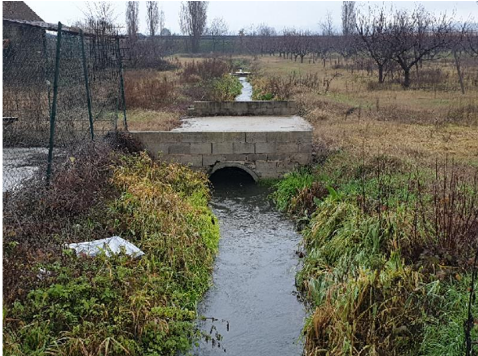
Figura 7 – Ponticello esistente a monte di via Pontara Sandri, vista verso l'autostrada
