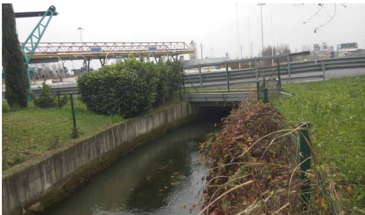
Figura 3 – Imbocco del tombino 4.00x2.00 a monte dell'attraversamento dell'A4 – IN15
