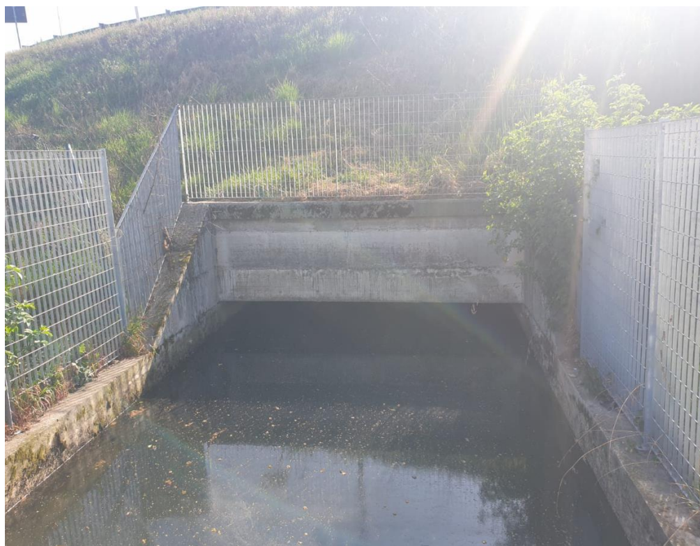
Figura 6 – Imbocco del tombino 4.00x2.00 a monte dell'attraversamento della rampa tangenziale sud – IN15
