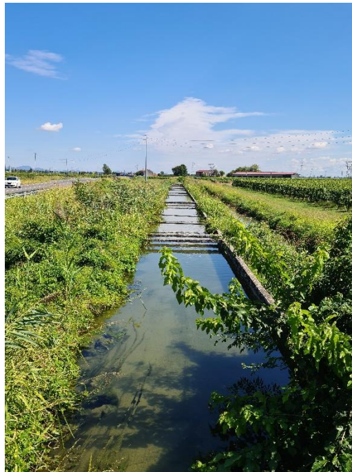
Vista del Canale Maestro in direzione sud-est a valle dello scatolare
