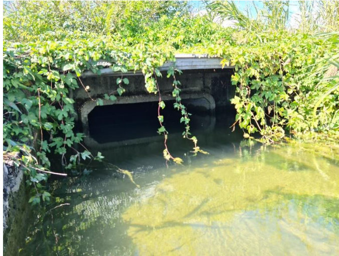
Vista del Canale Maestro allo sbocco dello scatolare sotto la strada Porcilana esistente
