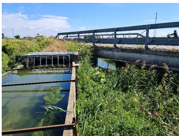
Vista del Canale Maestro all'imbocco del tombino sotto la strada Porcilana
