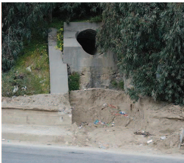
Figura 5: manufatto di sbocco del tombinamento al di sotto della sede autostradale
