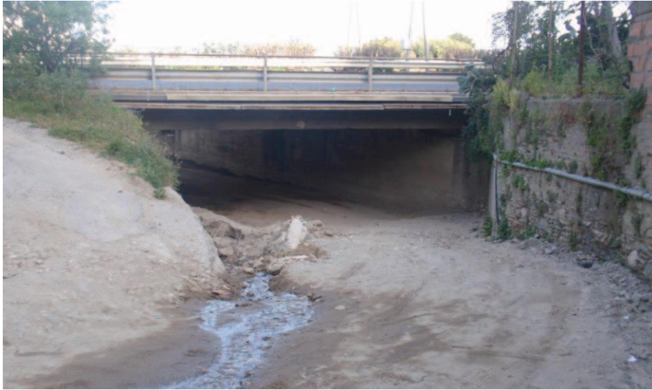
Figura 22: attraversamento autostradale visto da monte
