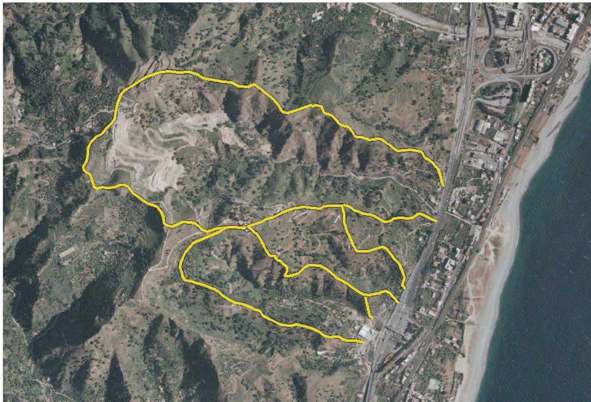
Fig. 1 – Veduta dell' area oggetto di studio: torrente Guidara (a), Canneto (b), Farota (c).
