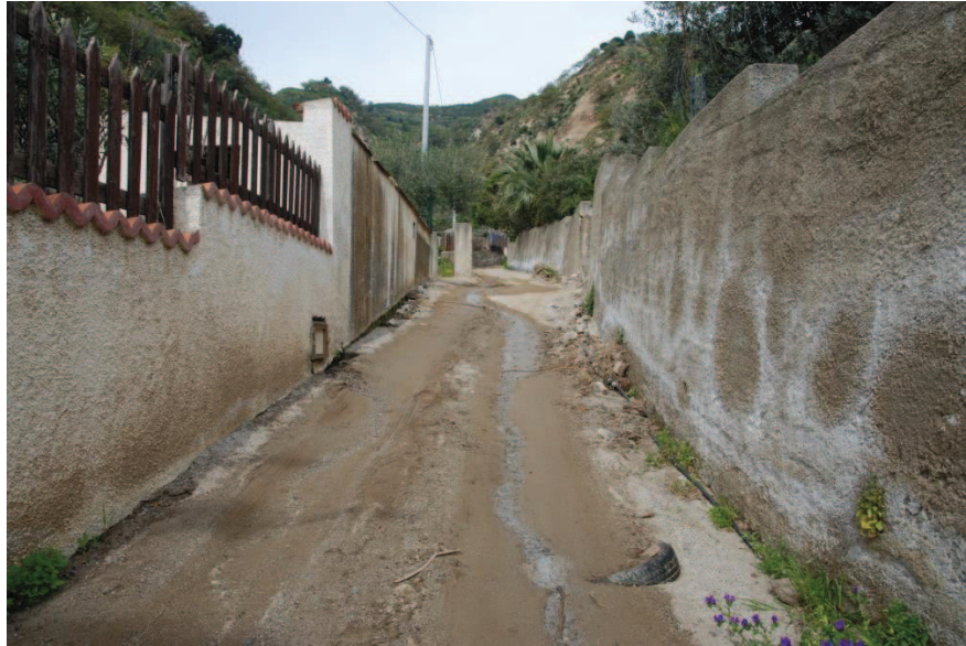
Figura 3: foto identificativa del tratto 2 del torrente Canneto
