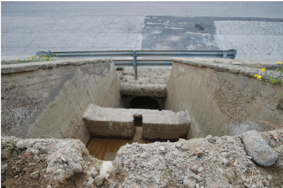
Figura 4: manufatto di ingresso del tombinamento al di sotto della sede autostradale
