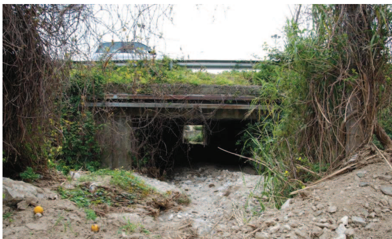
Figura 8: tratto 2 – manufatto di attraversamento autostradale
