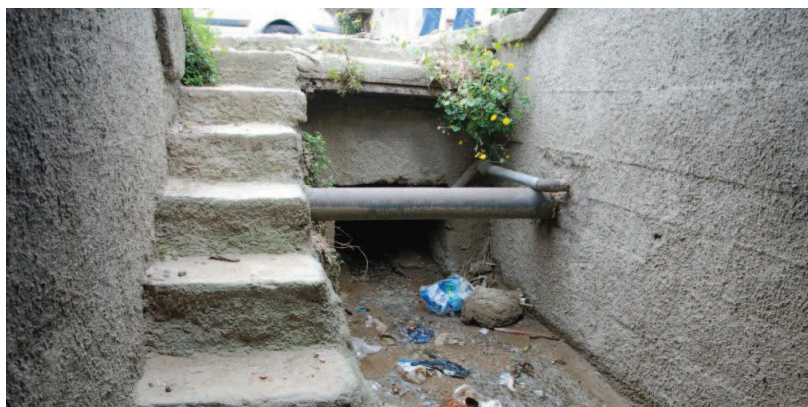
Figura 10: attraversamento strada statale
