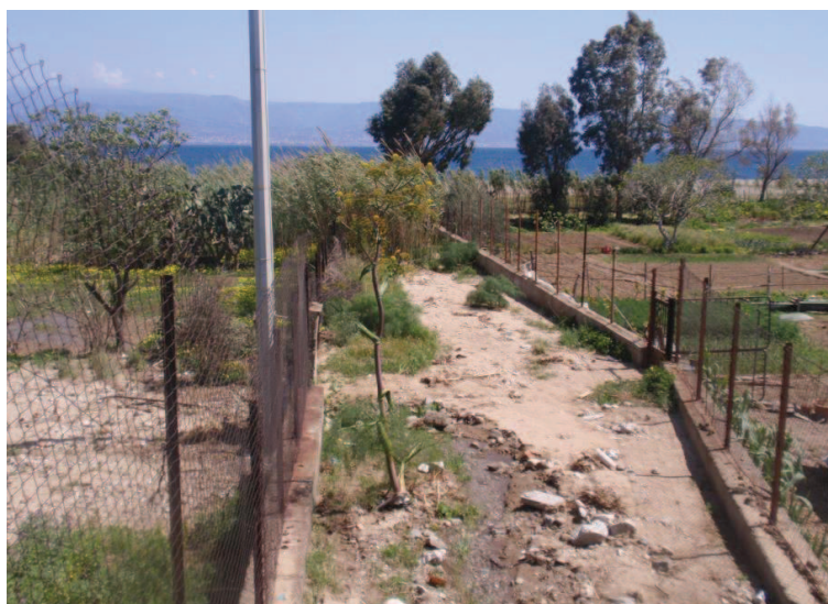
Figura 12: tratto a valle del rilevato della ferrovia.
