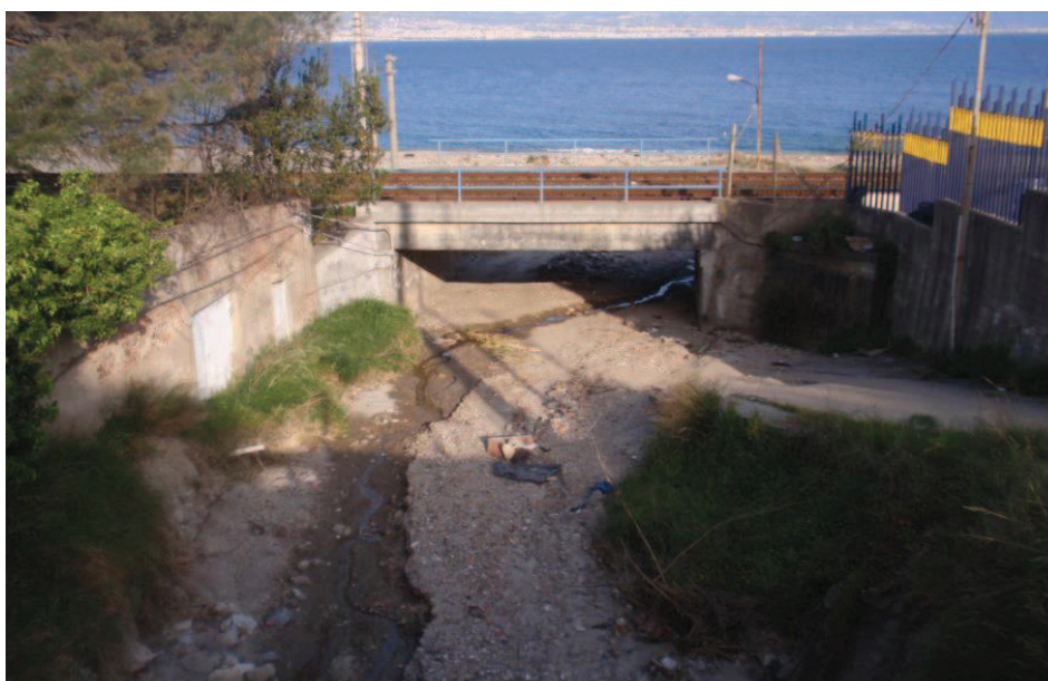
Figura 25: attraversamento della linea ferroviaria
