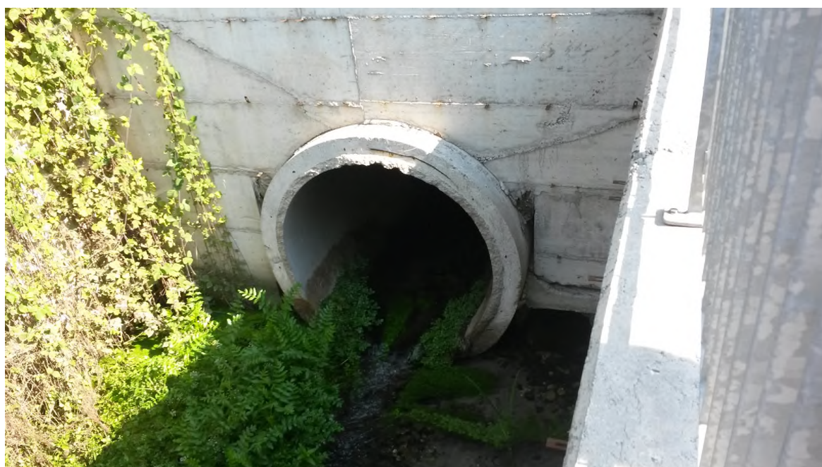
Figura 5 – Manufatto di valle esistente – collettore \varnothing 1600 in ingresso da monte
