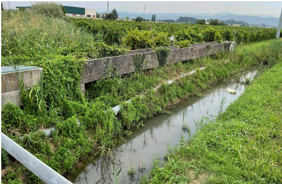
Vista diramazione canale Maestro lato Nord
