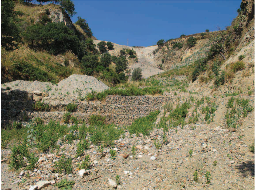
Fig. 5 – Gabbioni in pietrame e sullo sfondo la discarica di inerti.
