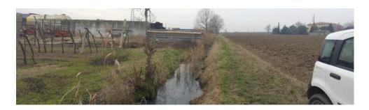
La portata di progetto relativa ad un tempo di ritorno di 200 anni è di 4.71 m³/s. Per ulteriori dettagli si rimanda all'elaborato IN1710EI2RHID0000002 "Relazione idrologica e idraulica attraversamenti secondari".
