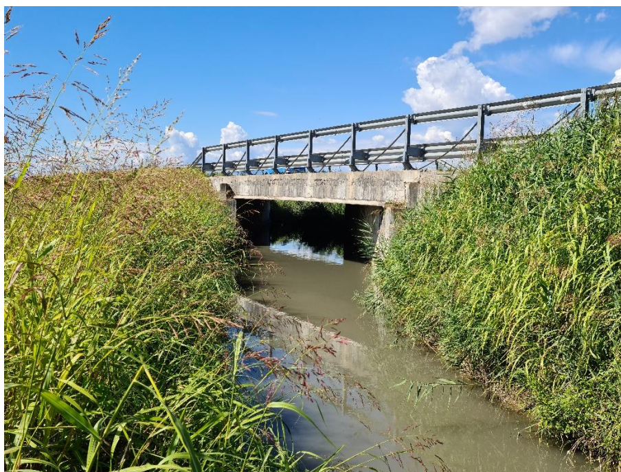
Vista dello scolo Masera Nord a sud del ponte della strada Porcilana
