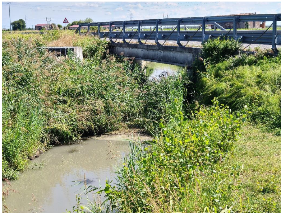
Vista dello scolo Masera Nord a nord del ponte della strada Porcilana
