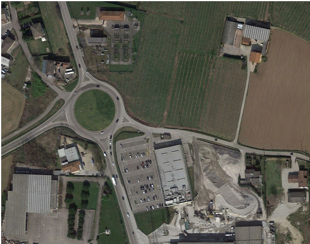
Figura 1: Stato di fatto
