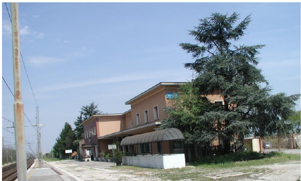
Figura 2 - Stato attuale – F.V. e l'accesso al sottopasso esistente: entrambi da demolire
