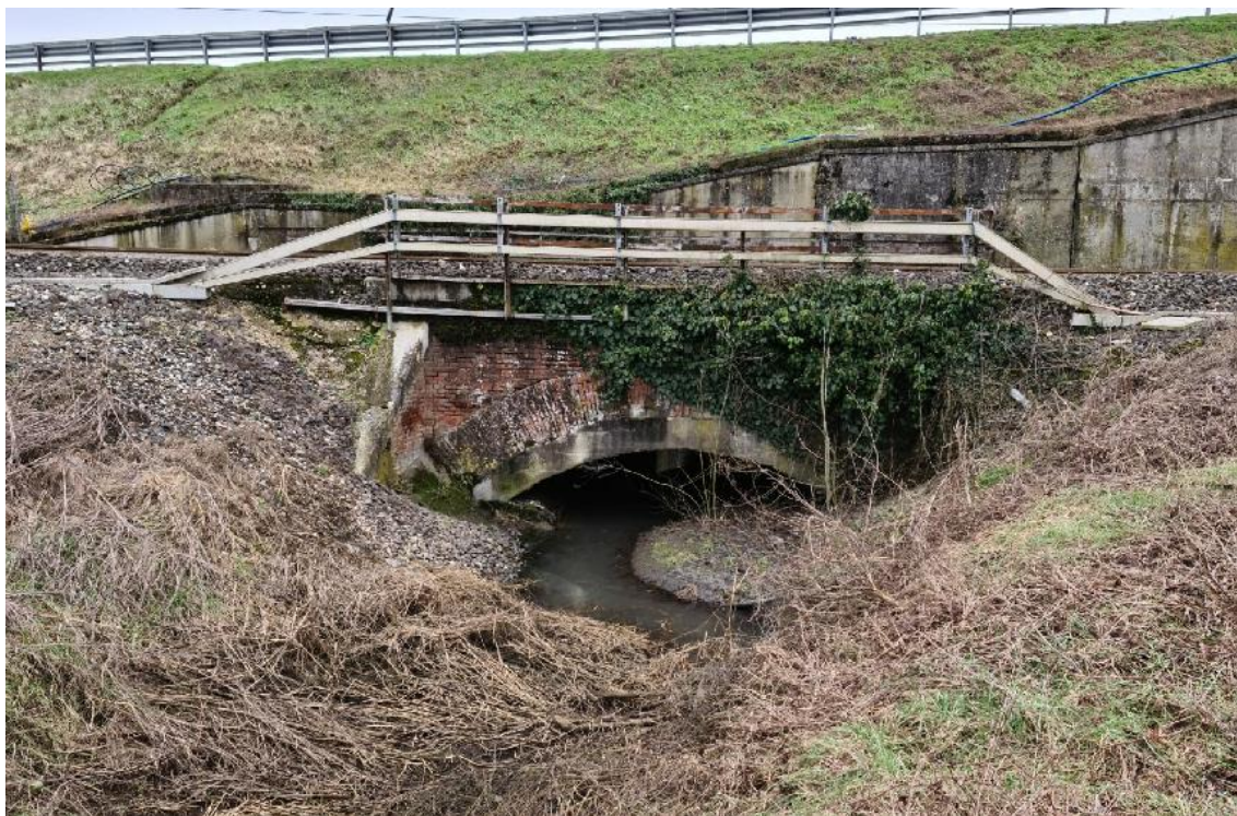
Figura 2 – Sezione di monte dell'attraversamento ad arco esistente sotto la ferrovia
