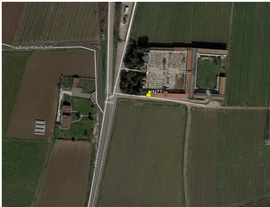
Figura 1: Stato di fatto
