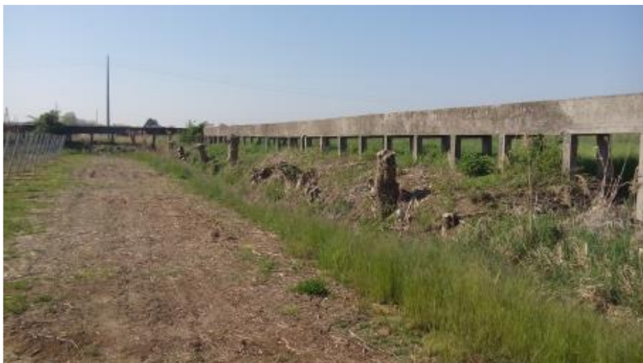
Vista della canaletta di derivazione a sud della strada Porcilana
